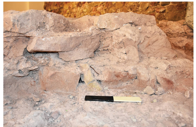
Abb. 4a/b Kern der Stadtmauer im Simeonstift in Bauweise aus wechselnden Lagen von Bruchstein und zähem Mörtel (Fotos M. Drechsler).
