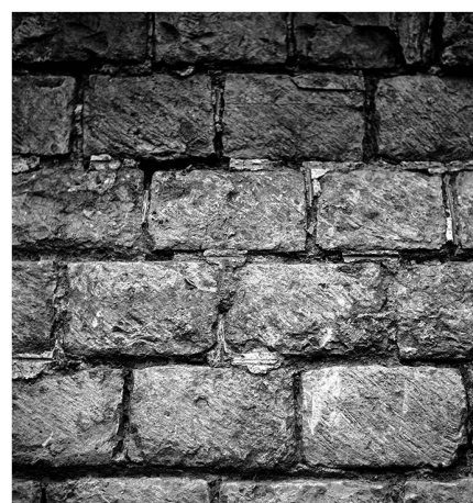
Abb. 5a/b Fugenstrich an der Stadtseite der Mauer im Schießgraben als Fotografie (Foto: Unbekannt, Bildarchiv: RE_1967_0374) und Zeichnung (Cüppers 1973, 143, Abb. 3).
