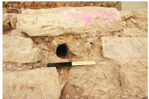
Abb. 13 Typische Auslassung eines Steins in der Mauerschale für die Verbindung des Mauer Kerns mit dem Baugerüst durch Rundhölzer (Stadtmuseum). Der Maßstab im Foto misst insgesamt 20 cm, die Oberflächen der Schalsteine sind größeren Teils beschädigt (Foto M. Drechsler).
