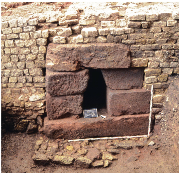
Abb. 3 Abwasserdurchlass in Blocktechnik aus Rostsandstein-Quadern im Simeonstift (Hupe 2011, 344, Abb. 77, Foto: K. Bissinger, Bildarchiv: TR_Simeonstift_EV2004_92_(90)). In derselben Art sind die Durchlässe am Moselufer (Kaiserstr) gearbeitet.
