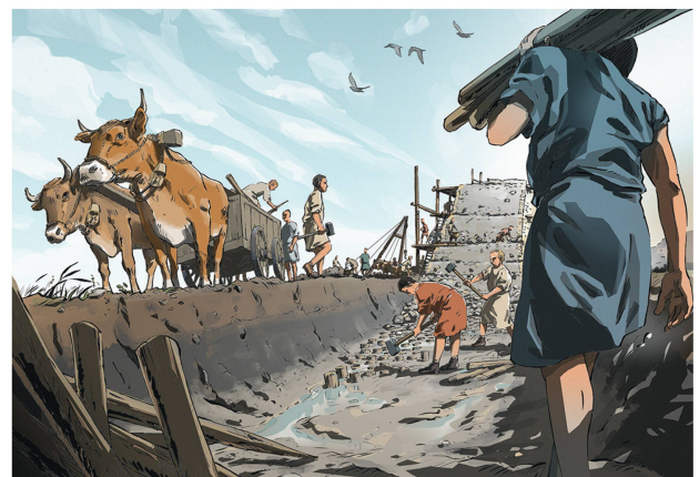
Abb. 12 Lebensbild mit einem Bauplatz an der Nordseite der Stadtmauer. Eichenpfähle werden von Hand oder mit Pfahlrammen in den dauerfeuchten Boden geschlagen. Im Hintergrund werden aufgehende Teile des Zweischalenmauerwerks aufgesetzt. Die Bauplätze werden kontinuierlich mit den benötigten Baumaterialien versorgt (Zeichnung B. Reymond SMRA).
