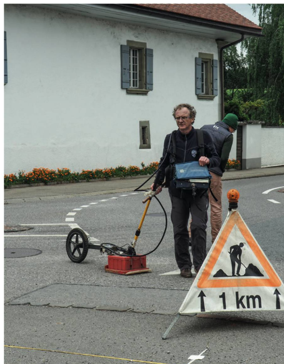
929 Georadar-Prospektion asphaltierter Strassenbeläge im Bereich der Kreuzung von Route d'Avenches/Route de Fribourg und Route de Villarepos (Prospektion 2016.08).
