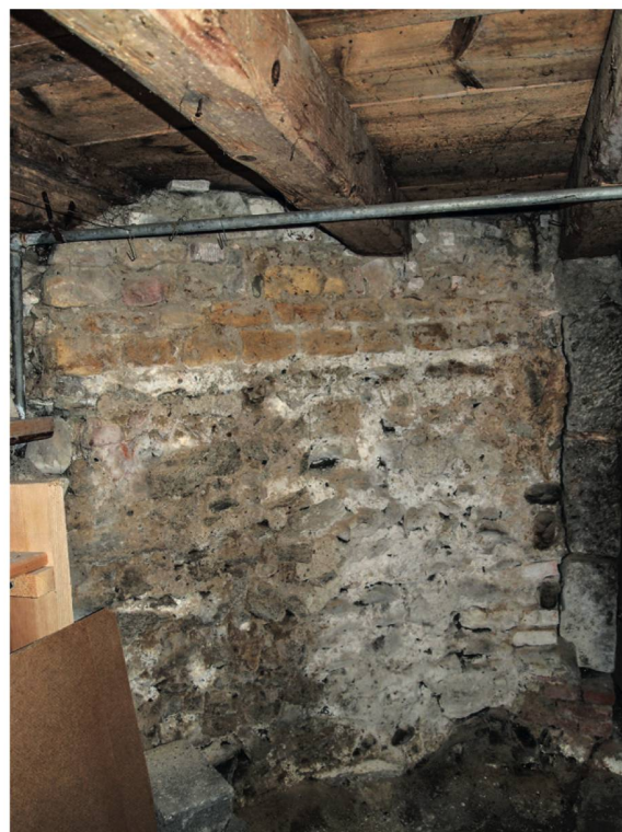
940 Nordwestwand des Kellers mit der erhaltenen Turmmauer T55_M1. Im unteren Bereich besteht diese aus Muschelsandstein (Fundament), während die maximal fünf erhaltenen, darüber folgenden Steinlagen aus Handquadern von Neuenburger Kalkstein (Sichtmauerwerk) gebaut sind. Oben wurde die Bodenkonstruktion des Erdgeschosses bzw. die Kellendecke direkt auf das antike Mauerwerk gesetzt. Am rechten Bildrand ist die Turmmauer für den modernen Kellereingang unterbrochen (2016).
