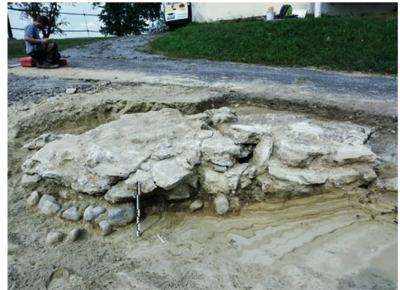
935 Fundamentrest von T54. An der UK des Fundamentes wurde eine trocken gesetzte Gerölllage eingebracht, darüber folgt das vermörtelte, hauptsächlich aus Muschelsandstein bestehende Fundament (Ausgrabung 2016.17).
