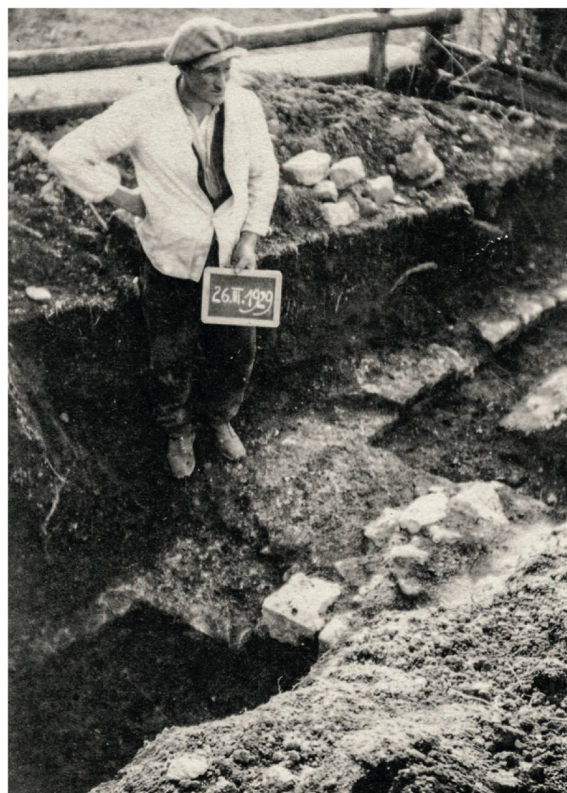
890 Detailaufnahme der gegen Osten von der Kurtine weg-führenden Turmmauer T37_M1 (26.3.1929).
