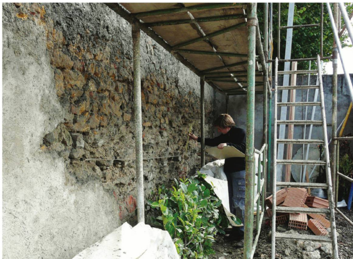
879 Teilstück T35–T36_M1, originales Kernmauerwerk in Verwendung als moderne Terrassenmauer. Links im Bild moderner Zementverputz (Ausgrabung 2012.08).
