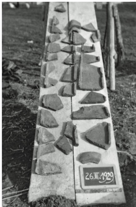
889 Aufstellung von anlässlich der Grabung von 1929 in T36 gefundenen Dachziegeln. Bei den besser erhaltenen Exemplaren ist deutlich die konische Grundform zu erkennen (26.3.1929).
