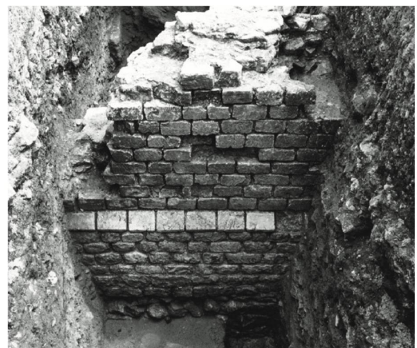
862 Nördliche Aussenseite von PO_M4 mit dem gefasten Fundamentvorsprung. An der Fundament-UK ist eine Lage aus trocken gesetzten Geröllern ersichtlich (Ausgrabung 1963.12).
