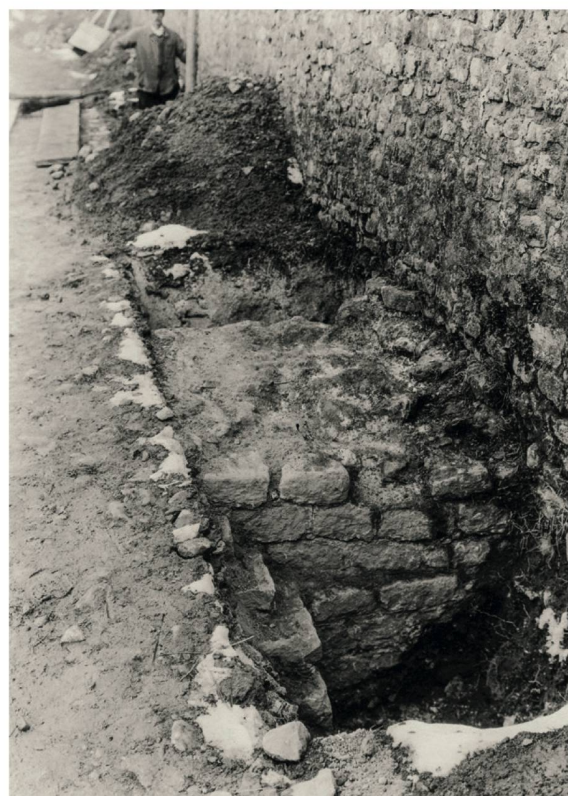
855 Aussenseite der Turmmauer T32_M1 mit regelmässigem Handquadermauerwerk. Links und rechts der Mauer setzten neuzeitlich-moderne Mauerstrukturen an (22.1.1929).
