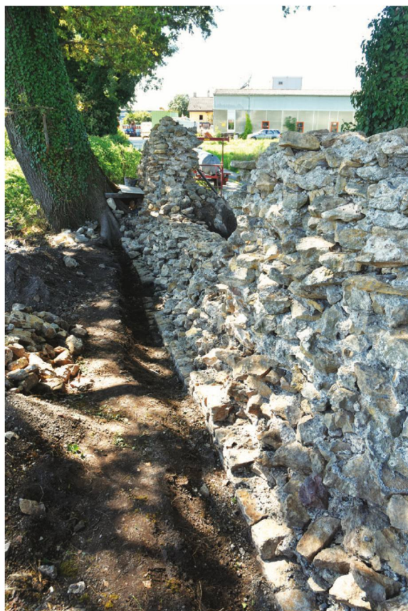
750 Teilstück PN-T17_M1 (Mauerinnenseite) mit bis auf das Niveau der OK des Fundamentvorsprungs erhaltener Mauerschale und darüber ansetzendem Mauerkern des aufgehenden Mauerwerks (Restaurierung 2015.06).
