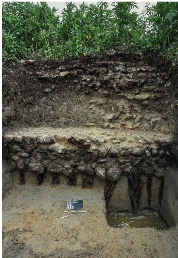
781 Teilstück T20–T21_M1 (vgl. Abb. 779), Ansicht des nördlichen Mauerseits mit intakten Resten des gemauerten Fundamentes und dem darunter ansetzenden Pfahlrost (Ausgrabung 2016.06).
