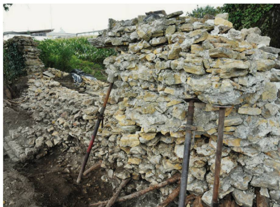
749 Teilstück PN-T17_M1 (Aussenseite) mit Kernmauerwerk und einem kurzen Abschnitt erhaltener Mauerschale im Bereich des Fundamentvorsprungs (unten links) (Restaurierung 2015.06).
