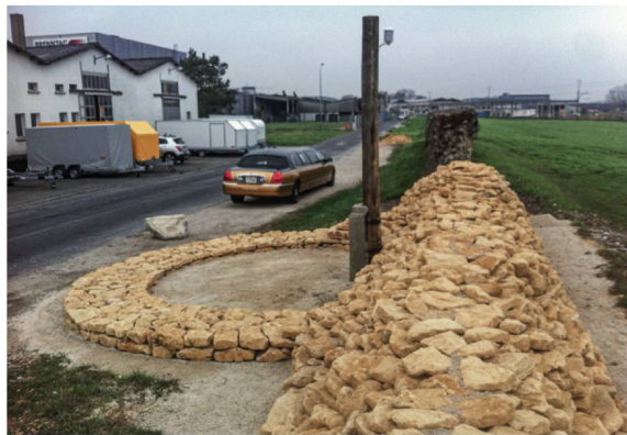
731 Blick von Osten auf den rekonstruierten Grundriss von T9. Im Zusammenhang mit der Überdeckung des original-antiken Mauerwerks der Kurtin durch ein Trockenmauerwerk (rechts im Bild) wurde der Turmgrundriss mit einer zweilagigen, trocken gesetzten Steinkonstruktion markiert. Im Inneren des Turmgrundrisses steht noch immer der 1922 angebracht Markierungspfahl (Zustand 2019).
