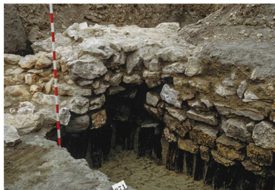
738 Blick in die Mauerecke zwischen T15_M1 (links) und Kurtine (rechts). Die beiden Fundamentkonstruktionen aus gemauertem Fundament und Pfahlrost wurden offensichtlich im Verband angelegt (Ausgrabung 1961.01).
