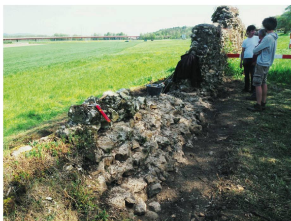
704 Freigelegte und gereinigte Kernmauerwerk der Kurtine (Teilstück T8–T9_M1), im Hintergrund die zwischen 1898 und 1902 restaurierten Mauerpartien (2018). Vgl. Abb. 61–62.
