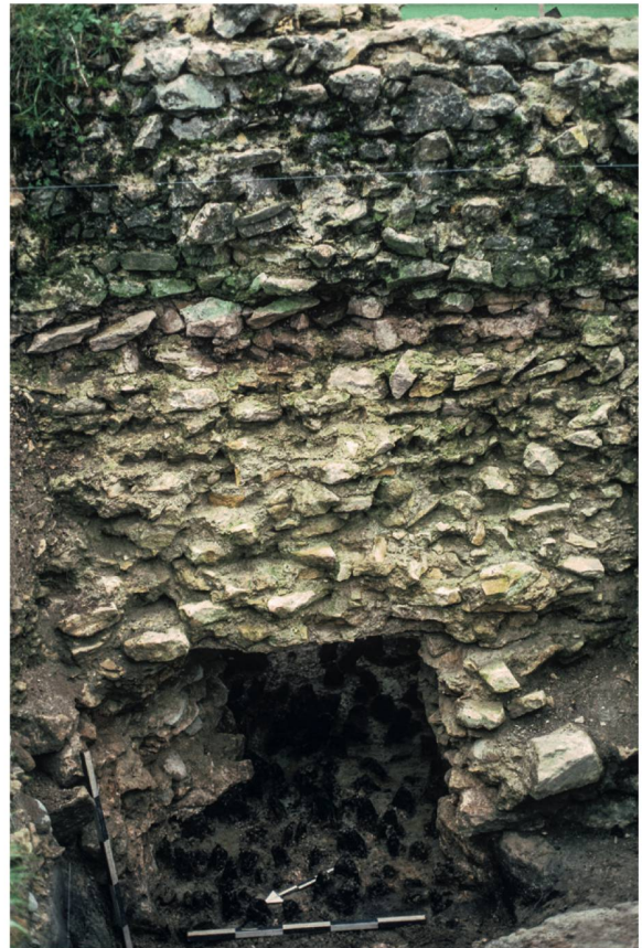
709 Schrägansicht der Mauerinnenseite (Teilstück T9–T10_M1) mit erhaltenem Kernmauerwerk. Im Bereich der unterhöhlten Mauerpartie setzen an der UK des gemauerten Fundamentes die dicht gesetzten Eichenpfähle an (Ausgrabung 1982.01).
