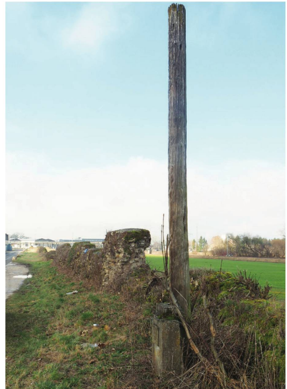
730 Standort von T9 mit dem 1922 angebrachten Betonsockel und Holzpfehl zur Markierung des Turmstandortes. Rechts im Bild der stark überwachsene und einsturzgefährdete Mauerkernel (Teilstück T9–T10_M1) (Zustand 2018).
