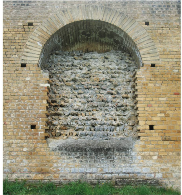
671 «Didaktisches Fenster» von 1928 an der Aussenseite der Kurtine, unmittelbar nördlich von T2, aktueller Zustand.
