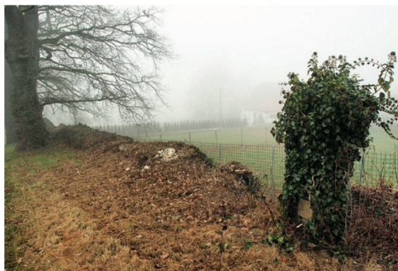
688 Aktuelle Situation am Standort von T5: Der Betonsockel von 1921 ist mit Efeu überwuchert, der ehemals darin verankerte Holzpfosten ist abgebrochen.
