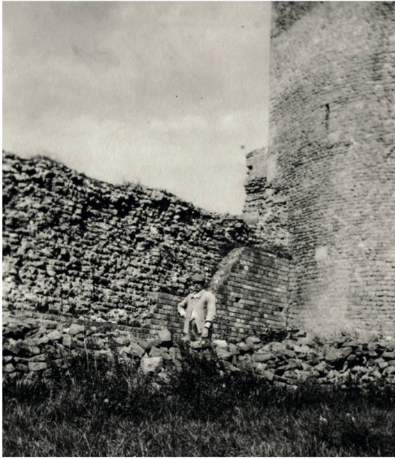
667 Kurine nördlich von T2 (T2–T3_M1) mit dem bis in eine Höhe von 5.46 m hoch erhaltenen Mauerkerne. Im unteren Bereich der Kurtine wurden Teile der inneren Mauerschale bereits restauriert (12.8.1927).
