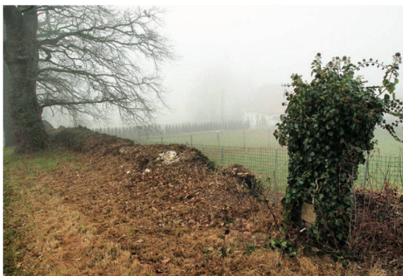
688 Aktuelle Situation am Standort von T5: Der Betonsockel von 1921 ist mit Efeu überwuchert, der ehemals darin verankerte Holzpfosten ist abgebrochen.
