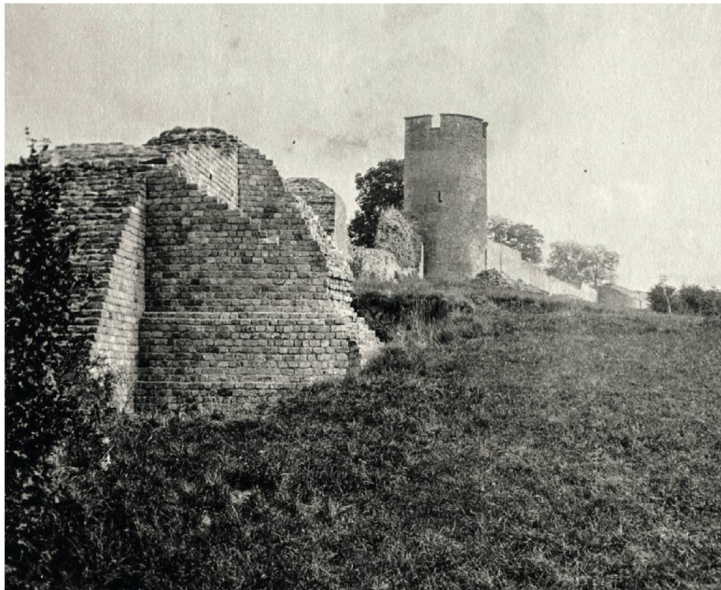
682 Ansicht des restaurierten Mauerwerks von T3 aus Norden. Der kraterartige Einschnitt an der Nordseite resultiert aus den Grabungen des frühen 20. Jh. (1917).
