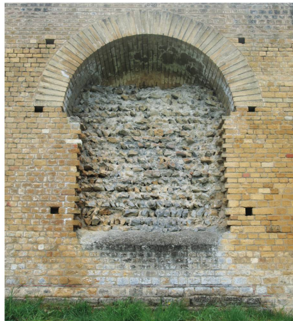
671 «Didaktisches Fenster» von 1928 an der Aussenseite der Kurtine, unmittelbar nördlich von T2, aktueller Zustand.
