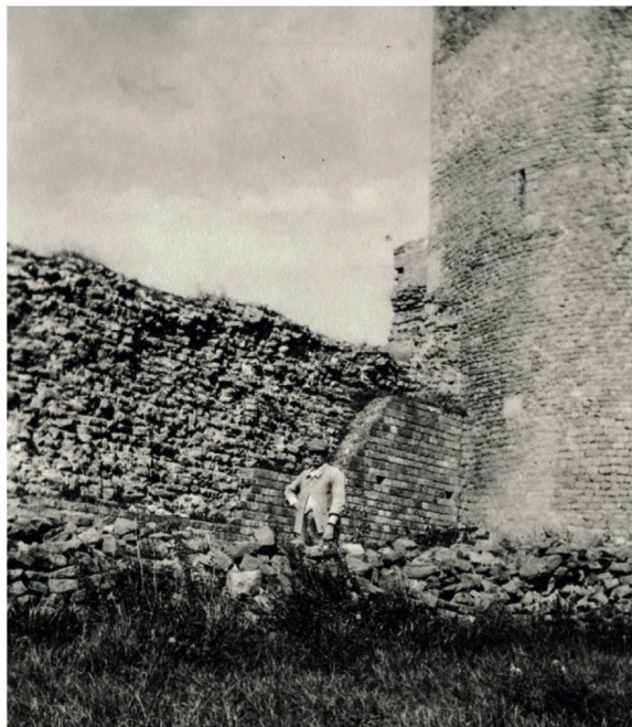
667 Kurine nördlich von T2 (T2–T3_M1) mit dem bis in eine Höhe von 5.46 m hoch erhaltenen Mauerkern. Im unteren Bereich der Kurtine wurden Teile der inneren Mauerschale bereits restauriert (12.8.1927).
