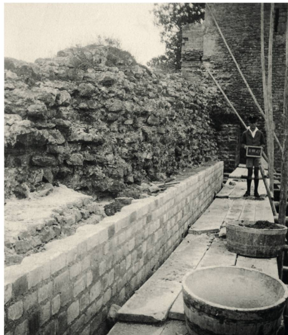
668 Auf dem Baugerüst nördlich von T2. Links im Bild ist der originale Mauerkern der Kurtine (T2–T3_M1) zu sehen, davor ist die Mauerschale aus Handquadern wieder aufgemauert worden. Im Hintergrund ist die Nordfassade von T2 mit anhaftenden Teilen der Kurtine erkennbar (12.8.1927).
