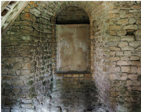
654 Blick auf die halbrund überwölbte Maueröffnung in T2_M5. In dieser ehemaligen Toröffnung wurde 1932 die Gedenktafel (vgl. Abb. 39) platziert. Anhand der Mauerfugen im Handquadermauerwerk sind die Übergänge zum Mauerwerk von T2_M4 zu erkennen.
