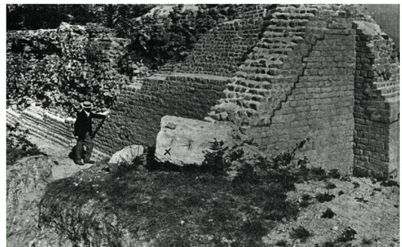
633 Östlicher Abschluss von PE_M1. Teile der originalen, südlichen Mauerschale in opus vittatum und oberhalb der farblichen Markierung restauriertes Mauerwerk (1898).
