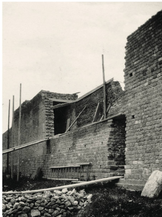
619 Restaurierungen am Teilstück T1–T2_M1. Auf den bestehenden, originalen Mauerkerne werden nach dem «System Siegwart» zwei Mauerschalen mit einer abschliessenden Betonplatten-Abdeckung aufgebaut (11.8.1917). Vgl. Abb. 45.
