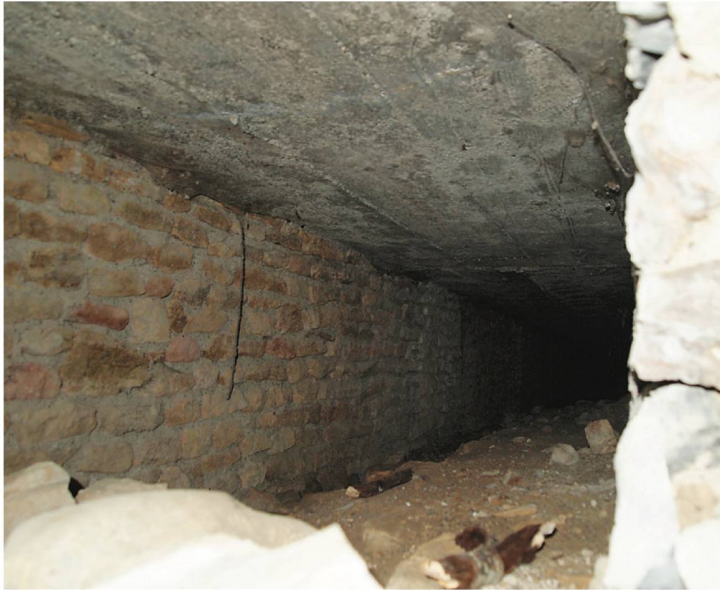
604 Blick in den Hohlraum des nach «System Siegwart» rekonstruierten Mauerwerks auf dem Teilstück PE-T73_M1. Am oberen Bildrand ist die Untersicht der Abdeckplatte aus Beton zu sehen (13.4.2016).
