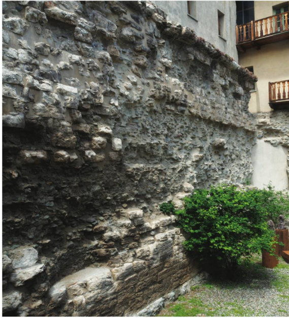
620 Stadtmauer von Aosta. Aussenseite der Kurtine südlich der Porta Praetoria. An der OK der Kurtine sind die gegen aussen vorkragenden Abdeckplatten des Wehrgangs in rund 5 m Höhe erhalten.
