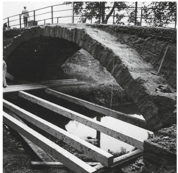
1941 abgebrochene Brücke über die Arbogne (DFI_PE1941_57_2)
