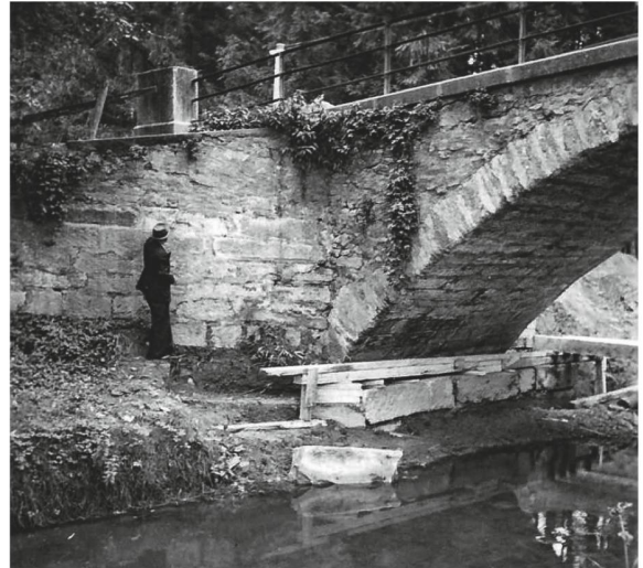
1941 abgebrochene Brücke über die Arbogne (DFI_PE1941_57_1)
