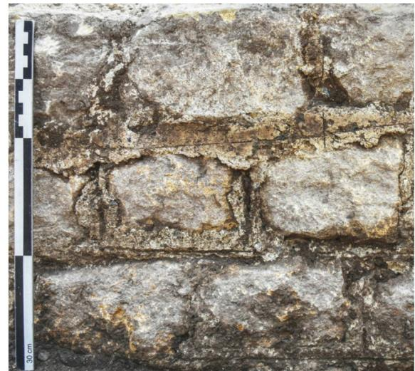
**259** Sondierung Nordosttor 2015.03. Detail des opus vittatum der Nordmauer (PNE\_M1) des Nordosttores. Gut erhaltener pietra rasa-Verputz und Fugenstrich zwischen den Handquadern aus gelbem Neuenburger Kalkstein (vgl. ■ 256).
