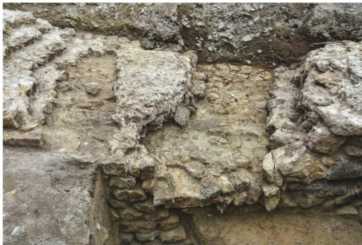
**88** Blick auf das Kurtinenteilstück PNE-T9\_M1. Im Vordergrund die stadtseitige Mauerschale der Kurtine. Der lagenweise Aufbau des Mauerwerks aus Kalkbruchsteinen und Mörtelschichten ist deutlich zu sehen. Die Baufuge rechts der Bildmitte entstand beim Neubau der Kurtine im Zusammenhang mit der Errichtung des Nordosttores anstelle des Turmes T8 (2015.03).
