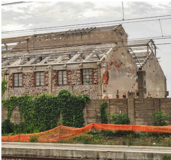
409 Pietra Ligure/It, ehemalige Werft «Cantieri navali» mit intentionell entfernter Dachhaut. Der offenliegende Dachstuhl ist vollständig der Witterung ausgesetzt (2018).
