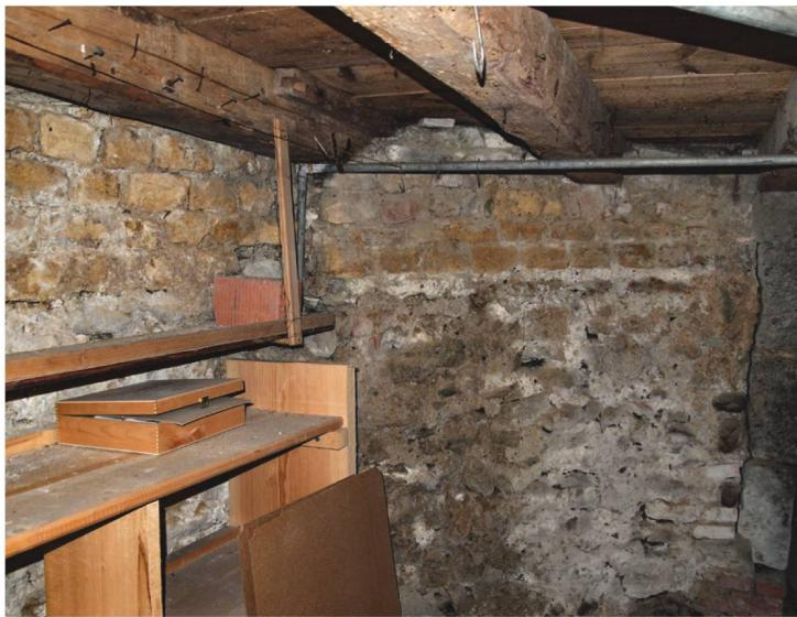
**528** Keller einer Wohnhäuser aus dem 19. Jh. in Donatyre. Für die Grundmauern des Kellers wurde der halbrunde Grundriss eines Turmes (T55) der flavischen Stadtmauer wiederverwendet. Das antike Mauerwerk ist hier bis in eine Höhe von 2.5 m erhalten. Am oberen Ende sind über dem Fundamentmauerwerk die untersten drei Steinlagen des opus vittatum erhalten.
