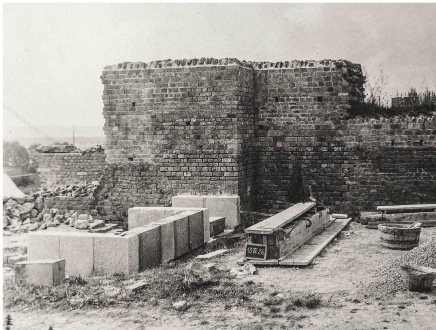
**146** Wiederaufbaurbeiten mit Kunststein-Quadern im Bereich der östlichen Fassadenmauer PE\_M10. In der Bildmitte ist eine hölzerne Schalung für den Guss von Romanzement-Quadern aufgebaut (1926).
