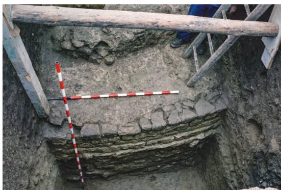
**304** Westtor, Turmmauer PO\_M1. Blick vom Turminnern gegen Aussen. Die Negative der Werksteine an der Aussenseite des im aufgehenden achteckig gestalteten Mauerwerks sind deutlich erkennbar (1963.12).
