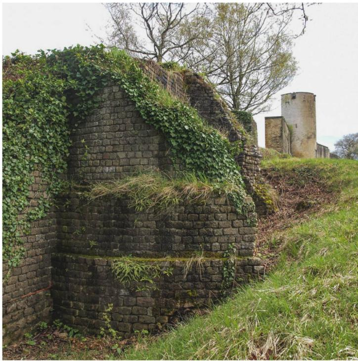
**401** Nordseite von T3. Die aufgehenden Mauerpartien des Turmes stoßen an das Mauerwerk der Kurtine. Mit Mauerrücksprüngen wurde das stark abfallende Gelände ausgeglichen, da man hier für den Turmbau eine ebene Plattform anlegen musste.
