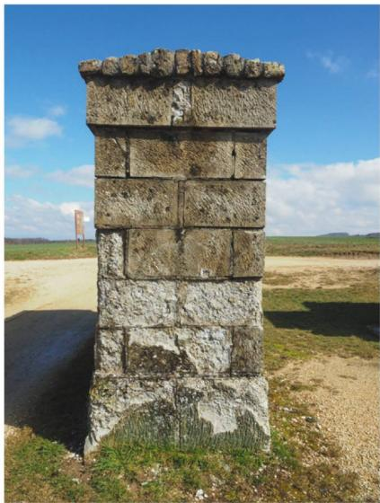
**150** Westseite des östlichen Mittelpfeilers PE\_M5. Von oben eindringende Feuchtigkeit hat zu Rissbildung und Abplatzungen an den Schalen der Kunststeinquader geführt.
