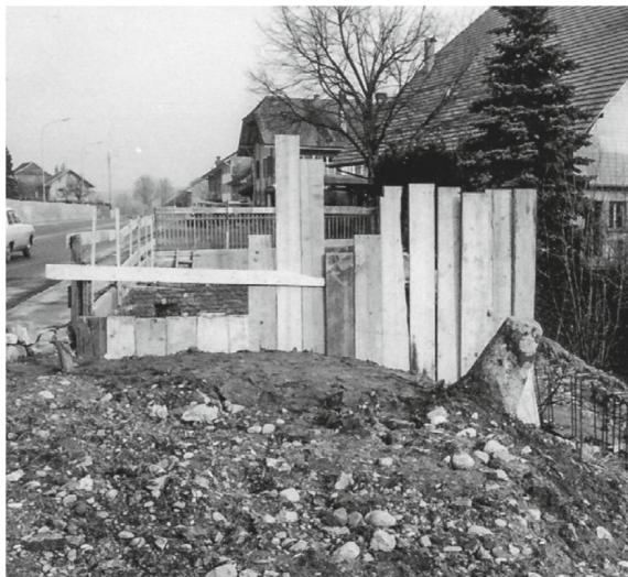
**296** Bauarbeiten an der Inszenierung der Ruine des nördlichen Torturmes (PO\_M1). Um die Ruine herum wurde ein Betongeviert gegossen, auf welches strassenseitig später eine Geländerkonstruktion aufgesetzt wurde (1966).
