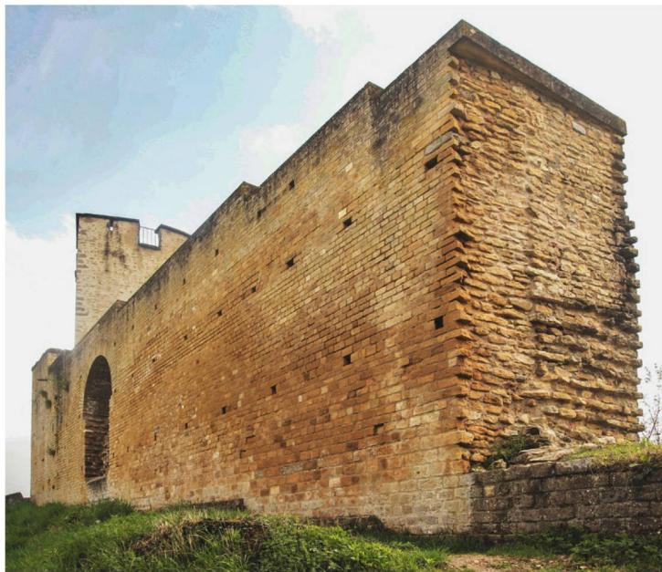
**101** Blick aus Nordosten gegen die Maueraussenseite nördlich von T2 (Teilstück T2–T3\_M1). In der rekonstruierten Mauerschale sind deutlich Gerüstlöcher in regelmässigen Abständen ersichtlich.
