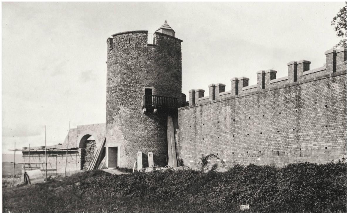
449 Bauarbeiten an T2: vom ehemaligen, mittelalterlichen Hocheingang aus wird der neu aufgebaute Wehrgang mit einer hölzernen Brückenkonstruktion erschlossen (1927).
