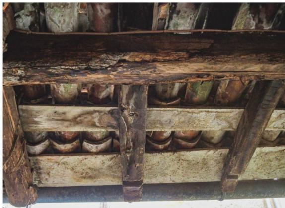
431 Untersicht der Dachkonstruktion in der Casa Libella in Pura/CH (19. Jh.). Sparren, Dachlatten und aufliegende Dachhaut aus Hohlziegeln. Die Überlappung der einzelnen Ziegel ist deutlich zu sehen.
