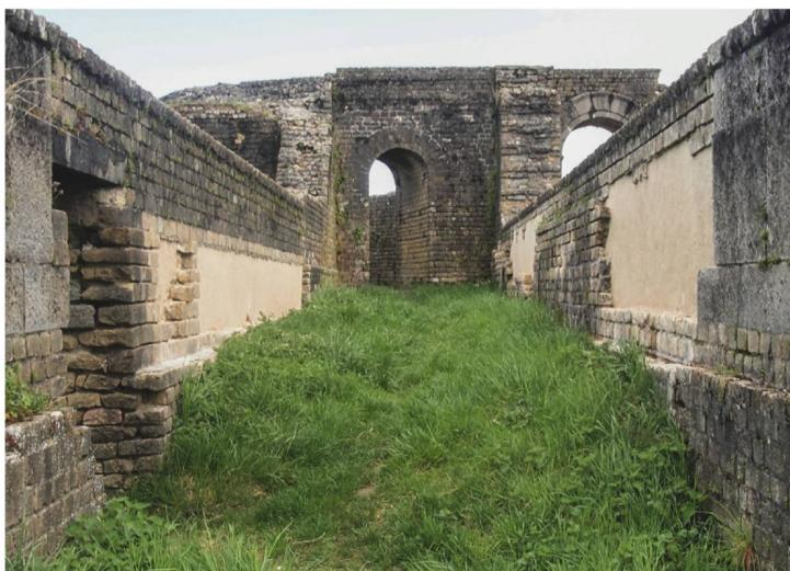
**152** Nördlicher Torturm PE\_M11. Infolge der vollständigen Auflösung des Mauer- mörtsels müssen am restaurierten Mauerwerk grössere Teile der Mauerschale neu gesetzt und ausgefugt werden. Hinter der ausgebrochenen Mauerschale ist der original-antike Mauerkern ersichtlich (2018).
