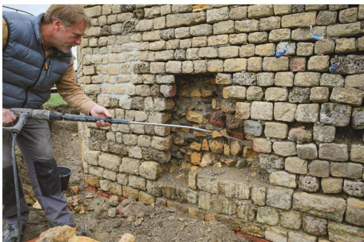
mörtel auf Basis von hydraulischem Kalk zur lokalen, provisorischen Sicherung des Mauerwerks am Osttor<sup>442</sup>
