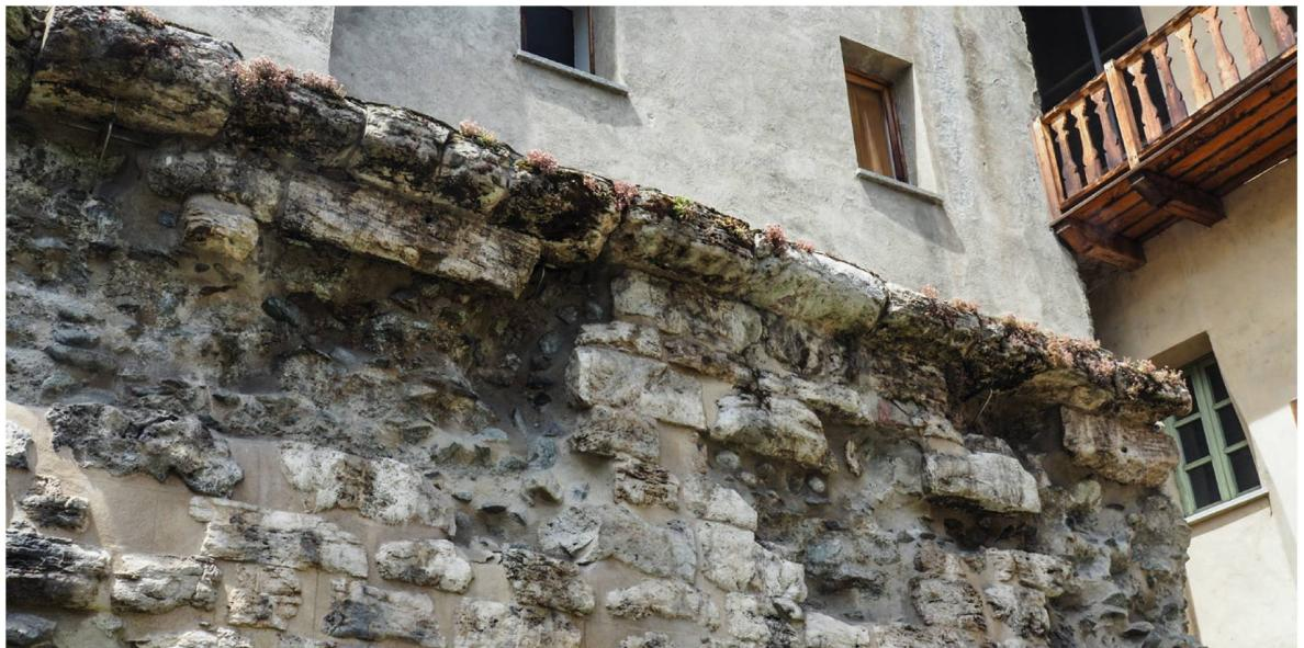
123 Stadtmauer von Aosta mit erhaltenem Gesims an der UK des Wehrgang-Niveaus (Maueraussenseite).
