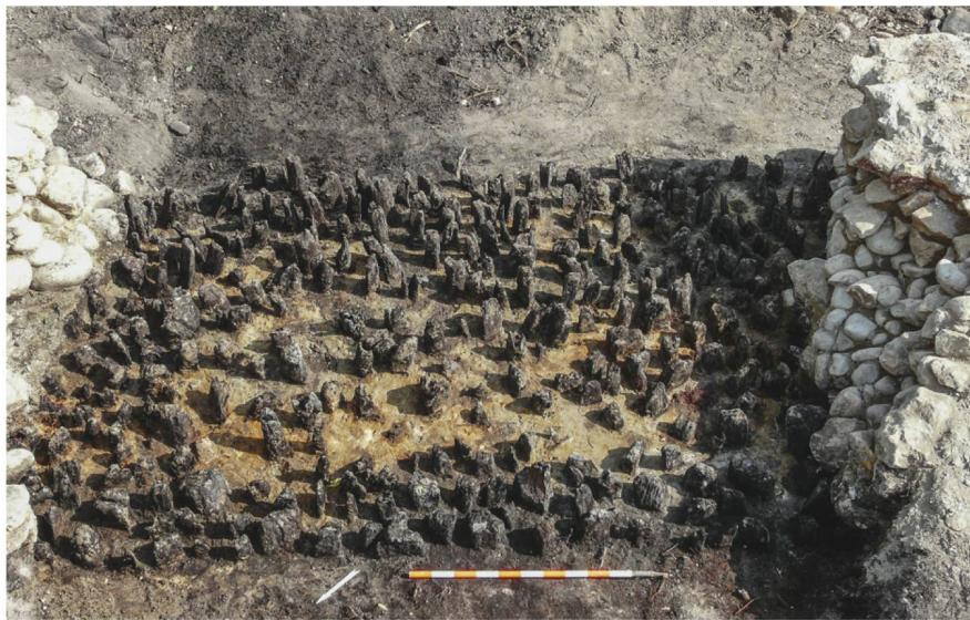
92 Kurtinenteilstück T17–T18\_M1. Blick auf den freigelegten Pfahlrost an der Basis des Mauerfundamentes. Links und rechts ist das darüberliegende, gemauerte Fundament zu erkennen (2008.09).
