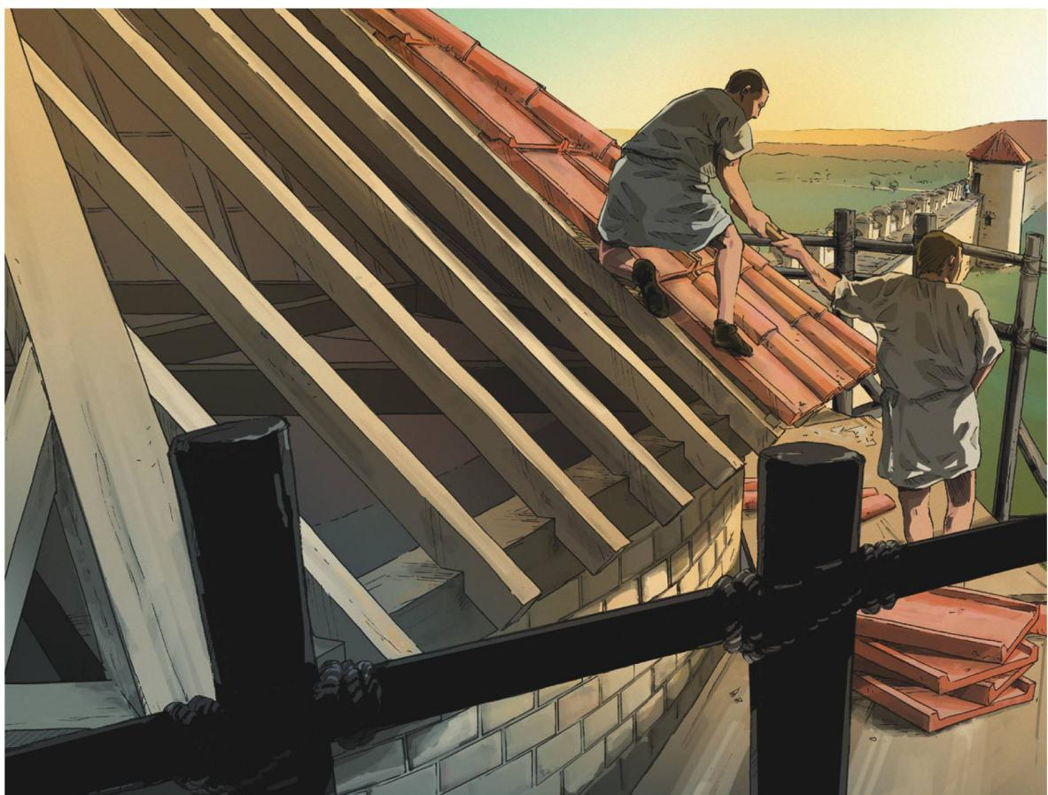
439 Lebensbild mit der Dachdeckung eines Turmes an der Stadtmauer von Aventicum. Die modularen, trapezförmigen Ziegel werden auf den hölzernen Dachstuhl aufgesetzt. Aufgrund der Neigung der Dachhaut muss der unterste Ziegel mit einem Nagel am Dachstuhl befestigt werden.
