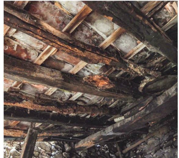
**435** Untersicht der Dachkonstruktion in der Casa Libella in Pura/CH (19. Jh.). Sparren, Dachlatten und aufliegende Dachhaut aus Hohlziegeln.
