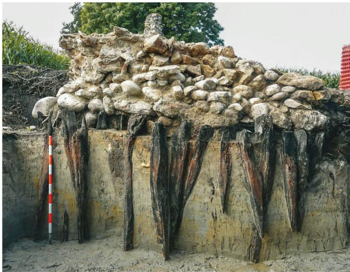
95 Querprofil durch die Kurtine (Teilstück T17–T18\_M1) mit Eichenpfahlrost an der Basis und dem darauf aufliegenden, gemauerten Fundament. Blick nach Westen (Stadtseite links, Landseite rechts) (2008.09).
