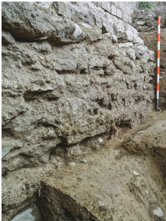
85 Kurtinenaussenseite Teilstück T73-PE\_M1. Blick gegen den oberen Teil des gegen den Dreck gemauerten Fundamentes der Kurtine aus Muschelsandsteinbrocken (2015.03).
