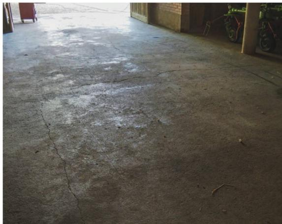
**290** Inneres der Scheune des Bauernhauses Jost. Im 1940 eingegossenen Betonboden zeichnen sich deutliche lineare Risse ab, die mit darunterliegenden älteren Mauerstrukturen, möglicherweise des Westtores in Bezug gesetzt werden. Vgl. Eintrag der Risse auf ■ 300.
