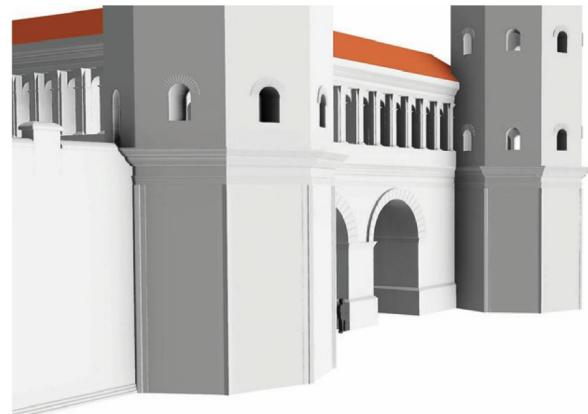
**328** 3D-Rekonstruktion Westtor. Detail der achteckigen Tortürme mit profilierten Orthostaten (Arch. 91) im Eckverband.
