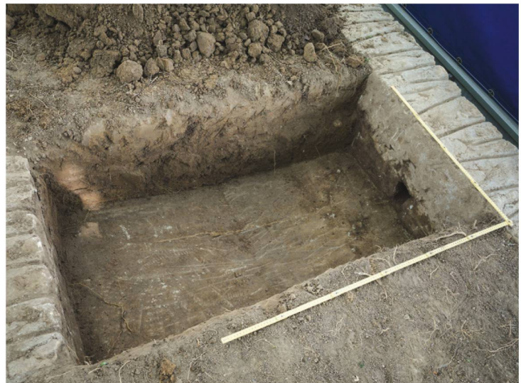
60 Restaurierungsarbeiten bei T73 (2018). Zwischen den beiden Anfang der 1930er Jahre restaurierten Mauerschalen ist ein Hohlraum zu sehen, der unten mit einer Betonplatte abschließt und der mit Erdmaterial aufgefüllt wurde.
