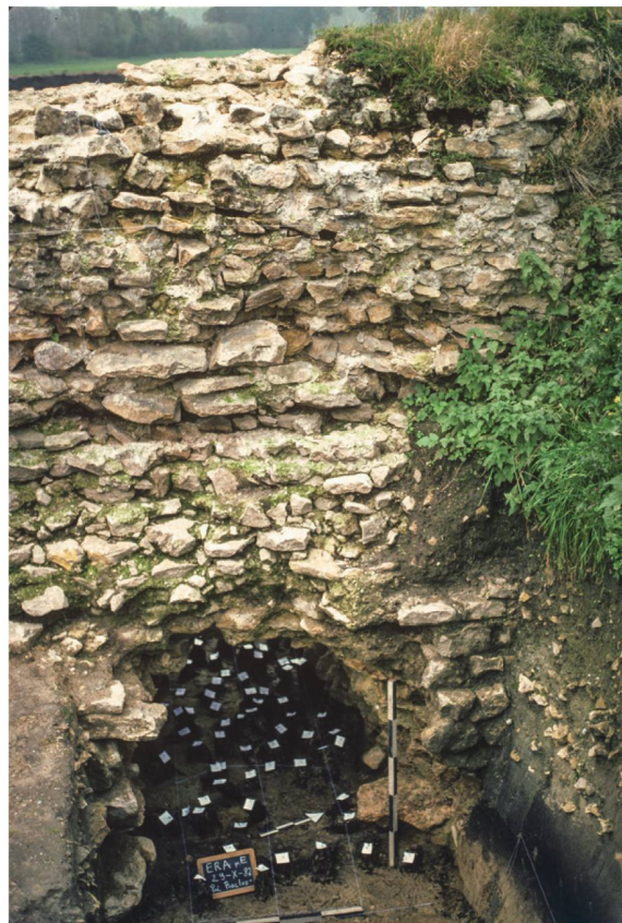
38 Abschnitt T III, Teilstück T9-T10_M1. Unterhöhlter Kern des Fundament und Sichtmauerwerks, unter dem der Rost aus Eichenpfählen zum Vorschein kommt (Ausgrabung 1982.01).
