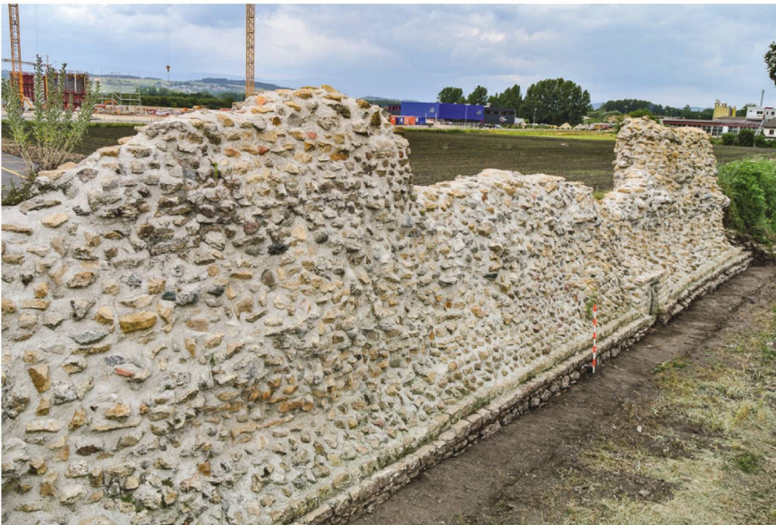
56 Bis zu 4 m hoch erhaltener Mauer Kern auf dem Teilstück T19–T20_M1. Zustand nach Abschluss der Restaurierung von 2013. Gegen den rechten Bildrand hin ist innerhalb der Mauer die Mündung eines Durchlasses für eine Abwasserleitung zu sehen (2013.07).
