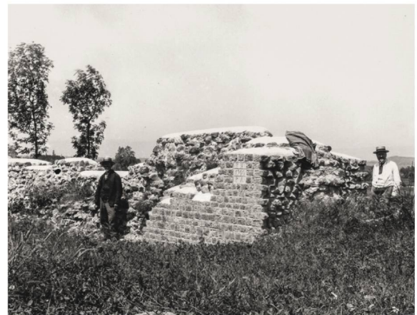
30 Ansicht der 1900 restaurierten und wiederaufgebauten Mauerpartie im Bereich La Maladeire (Foto nach 1902). Oben wurde das Mauerwerk mit Zementdeckeln geschlossen, gegen innen blendete man dem antiken Mauerkern neue Mauerschalen aus Handquadern vor. Links im Bild ist der Architekt Th. van Muyden zu sehen.
