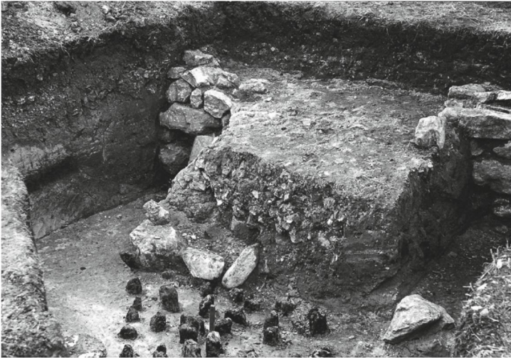
36 Ausgrabung von Turm T15 1961 (1961.01). In der Bildmitte ist deutlich die Pfahlfundamentierung des halbrunden Turmgrundrisses zu sehen. Am oberen Bildrand verläuft in West-Ost-Richtung die Stadtmauer.
