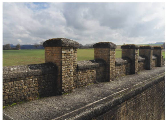
51 Heutiger Zustand des wiederaufgebauten Wehrganges mit Brustwehr inklusive Halbwalzensteinen und Zinnendeckeln aus Muschel-sandstein.
