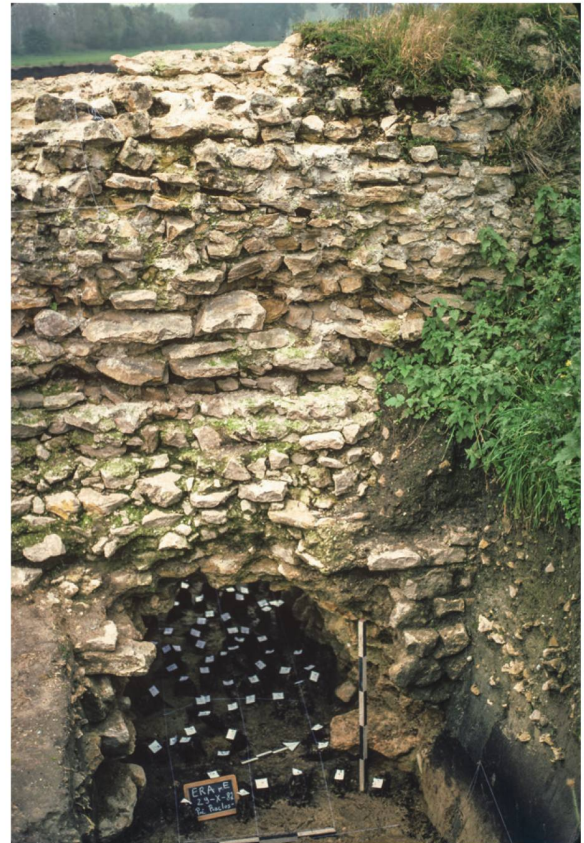
38 Abschnitt T III, Teilstück T9-T10_M1. Unterhöhlter Kern des Fundament und Sichtmauerwerks, unter dem der Rost aus Eichenpfählen zum Vorschein kommt (Ausgrabung 1982.01).
