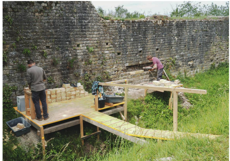
59 Restaurierungsarbeiten an der schadhafte äußeren Mauerschale zwischen T1 und T2. Zahlreiche infolge von Frostsprengungen geschädigte Handquader müssen ausgetauscht werden (2018).
