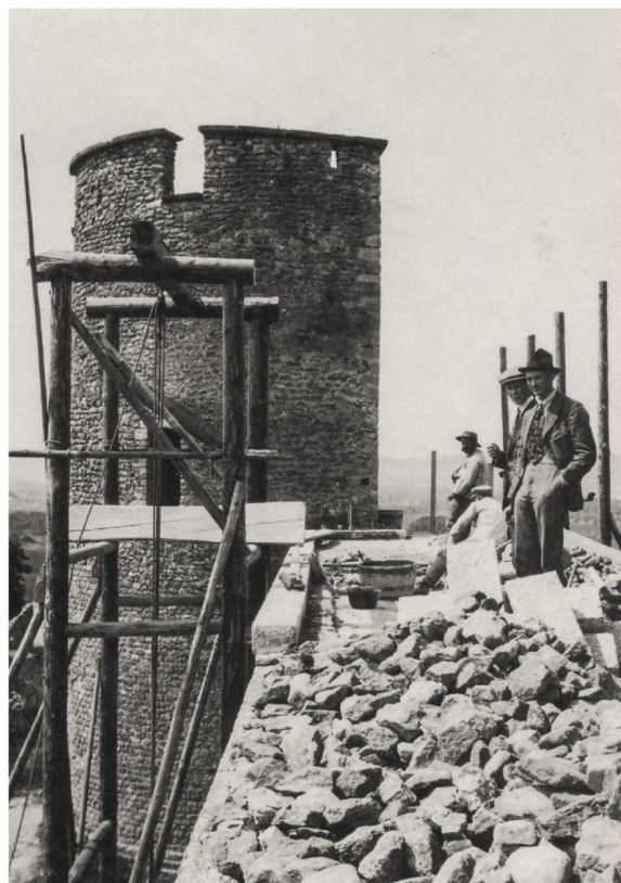
48 Aufmauerarbeiten im Bereich des rekonstruierten Wehrgangs im südlichen Anschluss an T2 (1919).
