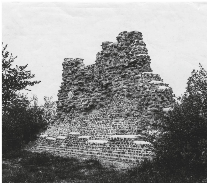
43 Ansicht der Mauerinnenseite im Bereich La Vignette A, Teilstück T45–T46_M1 (Zustand nach Abschluss der Restaurierung 1904).
