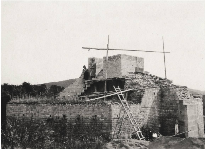
63 Aufbau einer Aussichtsplattform über dem südlichen Torturm des Osttores (PE_M12) (1929).
