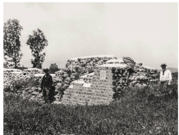
30 Ansicht der 1900 restaurierten und wiederaufgebauten Mauerpartie im Bereich La Maladeire (Foto nach 1902). Oben wurde das Mauerwerk mit Zementdeckeln geschlossen, gegen innen blendete man dem antiken Mauerwerk neue Mauerschalen aus Handquadern vor. Links im Bild ist der Architekt Th. van Muyden zu sehen.
