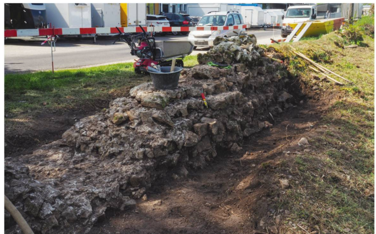
61 Freigelegter und gereinigter Mauerkern auf dem Abschnitt T8–T9. Anschliessend wurde das originale Mauerwerk mit einer Trockenmauer aus Kalkbruchsteinen überdeckt (2019).
