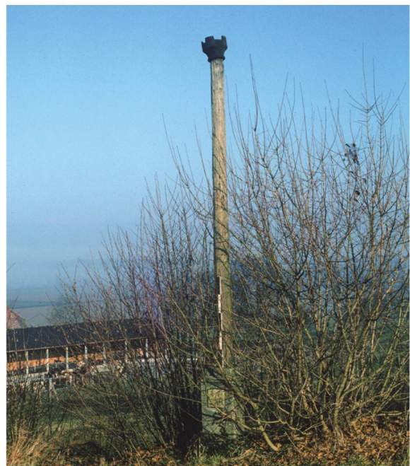
53 Detailaufnahme des Betonsockels zur Aufnahme einer Holzpfosten-Konstruktion zur Markierung von Turmstandorten. Auf einer Zementplakette war die betreffende Turmnummer angebracht (L. Bosset, 1924).
