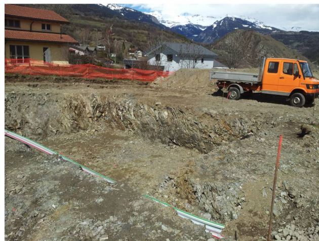
Fig.35 – Maison Quarroz (2013). Le rocher affleure directement sous un niveau de colluvions et la terre végétale. Vue depuis le sud-ouest.
