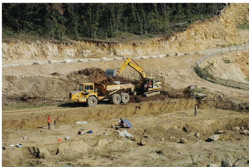
Fig. 2. Engins de terrassement décapant les terres superficielles devant les archéologues, septembre 2006.
