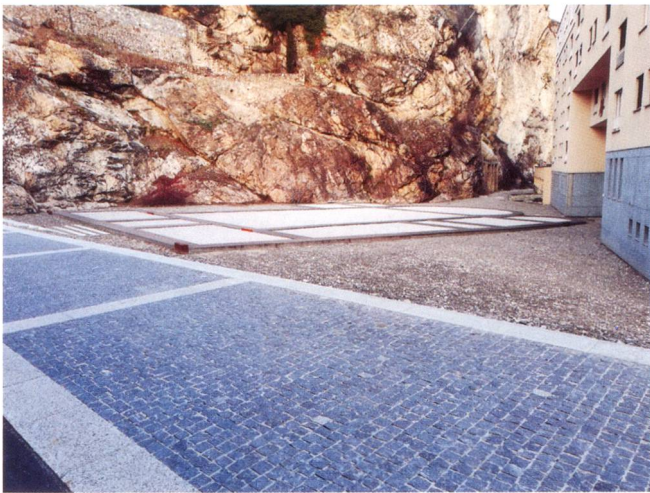
Fig. 208 – Aménagement de la promenade supérieure et du site en contrebas en 2019.
