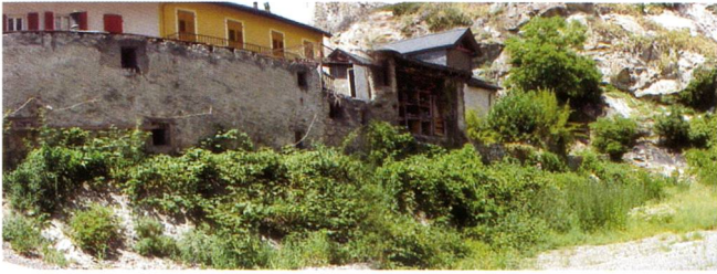
Fig. 198 – Vue des bâtiments de la frange ouest en 2005, avant leur démolition.
