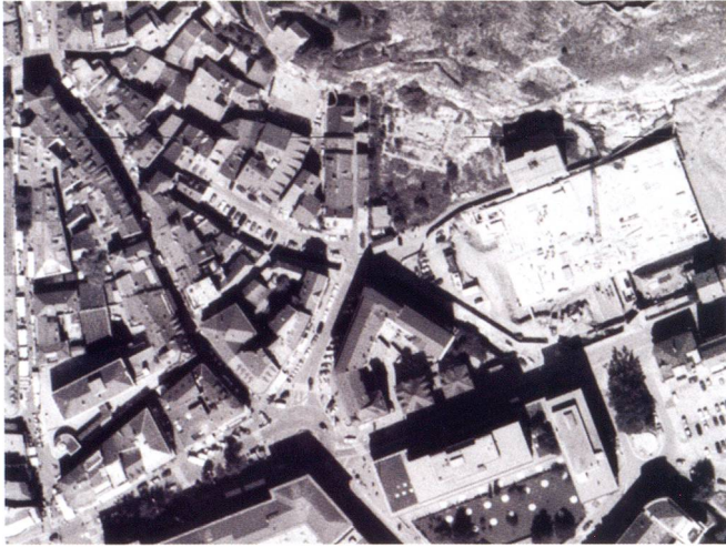
Fig. 188 – Vue aérienne en 1998, lors de la construction du Parking du Scex.
