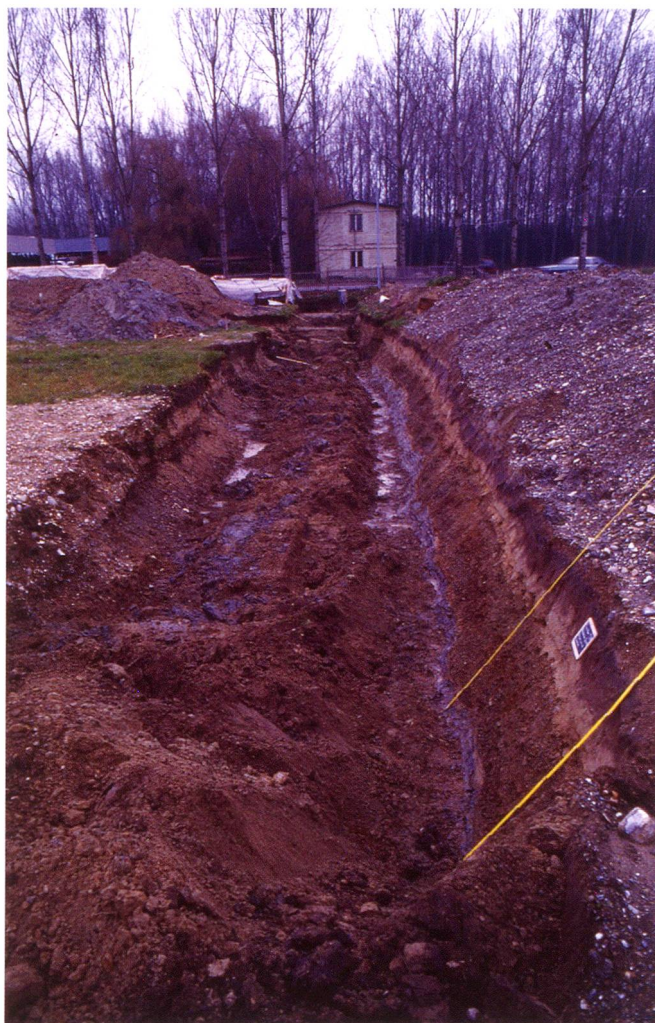
Fig. 93. Partie amont de la tranchée 1988, perpendiculaire à l'Avenue des Sports, coupe à travers un cordon de graviers (détail voir fig. 94) ; vue en direction du nord, photo C. Wolf.
