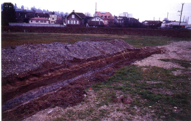
Fig. 27. Tranchée perpendiculaire à l'Avenue des Sports à l'est du site, en 1988, on voit très bien les graviers gris du cordon littoral sur le tas de déblais. Dans le profil, ce dernier plutôt brun apparaît sous le sable jaune et surmonte une couche d'argile gris-bleuté. A l'arrière-plan, on distingue le talus de la ligne de chemin de fer Yverdon-Yvonand, photo C. Wolf.
