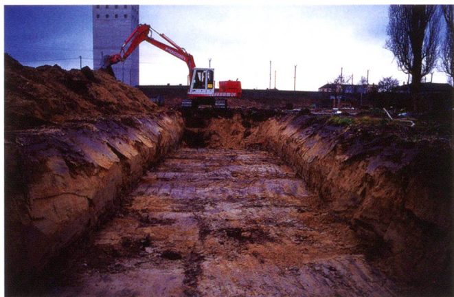
Fig. 113. Nouvelle canalisation UCAR, tranchée complémentaire, perpendiculaire à l'Avenue des Sports, réalisée en 1989 en bordure ouest de la parcelle n° 1846 ; vue en direction du sud avec au fond la voie ferrée et la « tour Landi », photo C. Wolf.
