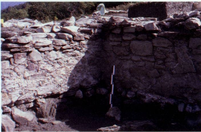
Fig. 156 – Bâtiment Bat1. Détail des murs en élévation à l'intérieur de l'édifice. Le radier du sol est par endroit encastré dans la masse du mur entre la fondation et l'élévation. Vue depuis le nord-ouest.
