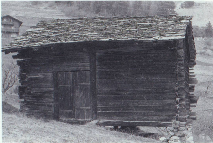
Fig. 175 – Près de Vens (Vollèges). Raccard reposant sur des murets. Ce type de disposition dans la pente est attesté dans l'agglomération de Gamsen. Tiré d'ANDEREGG et al. 2011, p. 276, fig. 11.22.
