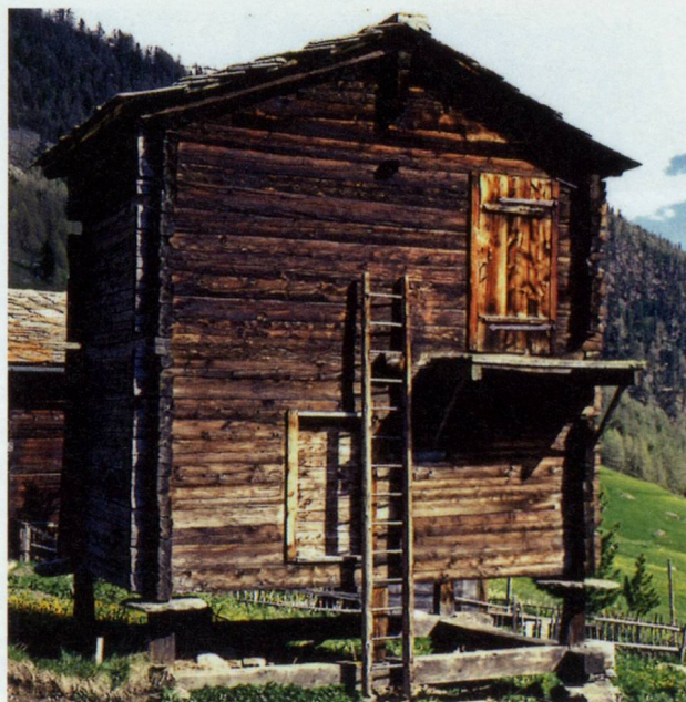
Fig. 174 – Hameau de Ze Hischinu - Gspon, au-dessus de Staldenried. Grenier sur deux niveaux reposant sur des quilles de bois aménagées sur un cadre de bois. Tiré d'ANDEREGG et al. 2011», p. 257, fig. 10.15.
