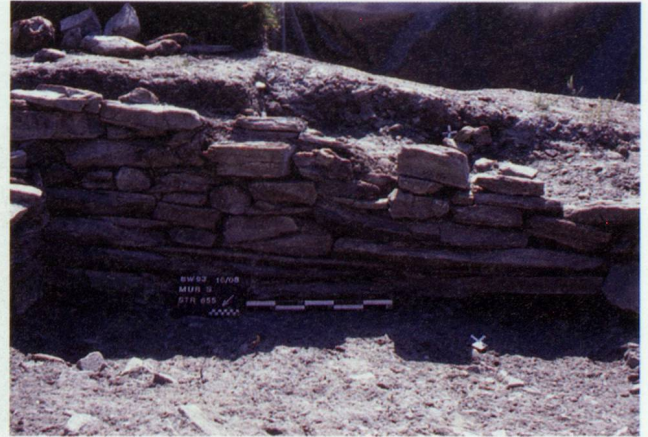
Fig. 140 – Bâtiment Bat23. Détail du parement intérieur du mur sud, constitué de lits de pierres soigneusement réglés. Vue depuis le nord.
