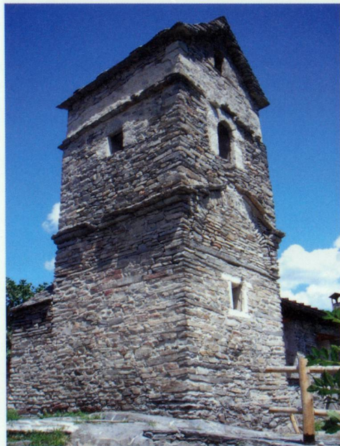
Fig. 160 – Temple de Roldo (I). L'édifice a été intégré à une tour de garde au XIII e siècle. On distingue encore dans la façade sud le volume initial du monument avec une toiture à deux pans. Vue depuis le sud-ouest.
