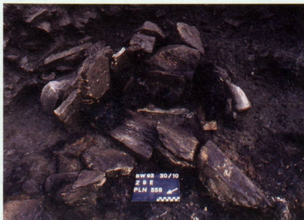
Fig. 104 – Bâtiment Bat11. Détail de l'angle sud-est, protégé par des dalles verticales. Les sablières sont croisées à mi-bois et l'angle renforcé par un poteau cornier (quart de tronc conservé). Vue depuis l'ouest.
