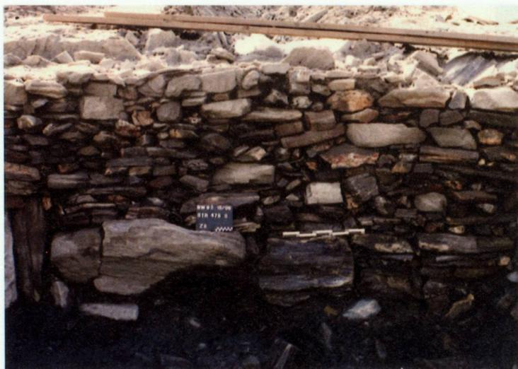
**Fig. 136** – Bâtiment Bat13. Détail de l'appareillage du mur sud. Les modules de pierre sont plus gros à la base du mur et plus petits en élévation. Vue depuis le nord.
