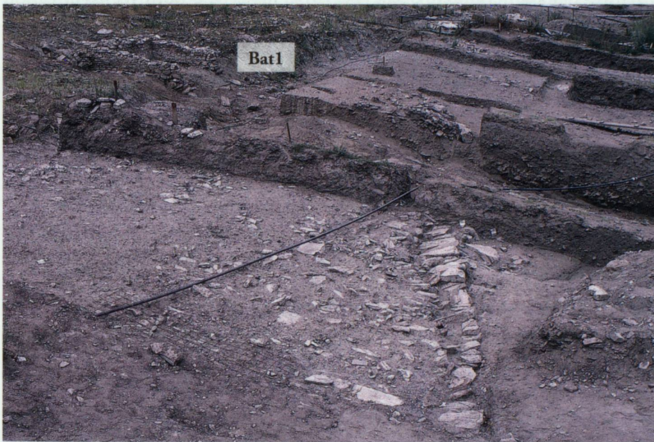
Fig. 21 – Voie 8. Le chemin d'accès au bâtiment Bat1 (en haut à gauche) est consolidé au cours du II e siècle (R2B) par la mise en place d'un accotement constitué de grosses dalles. Vue depuis le nord-est.
