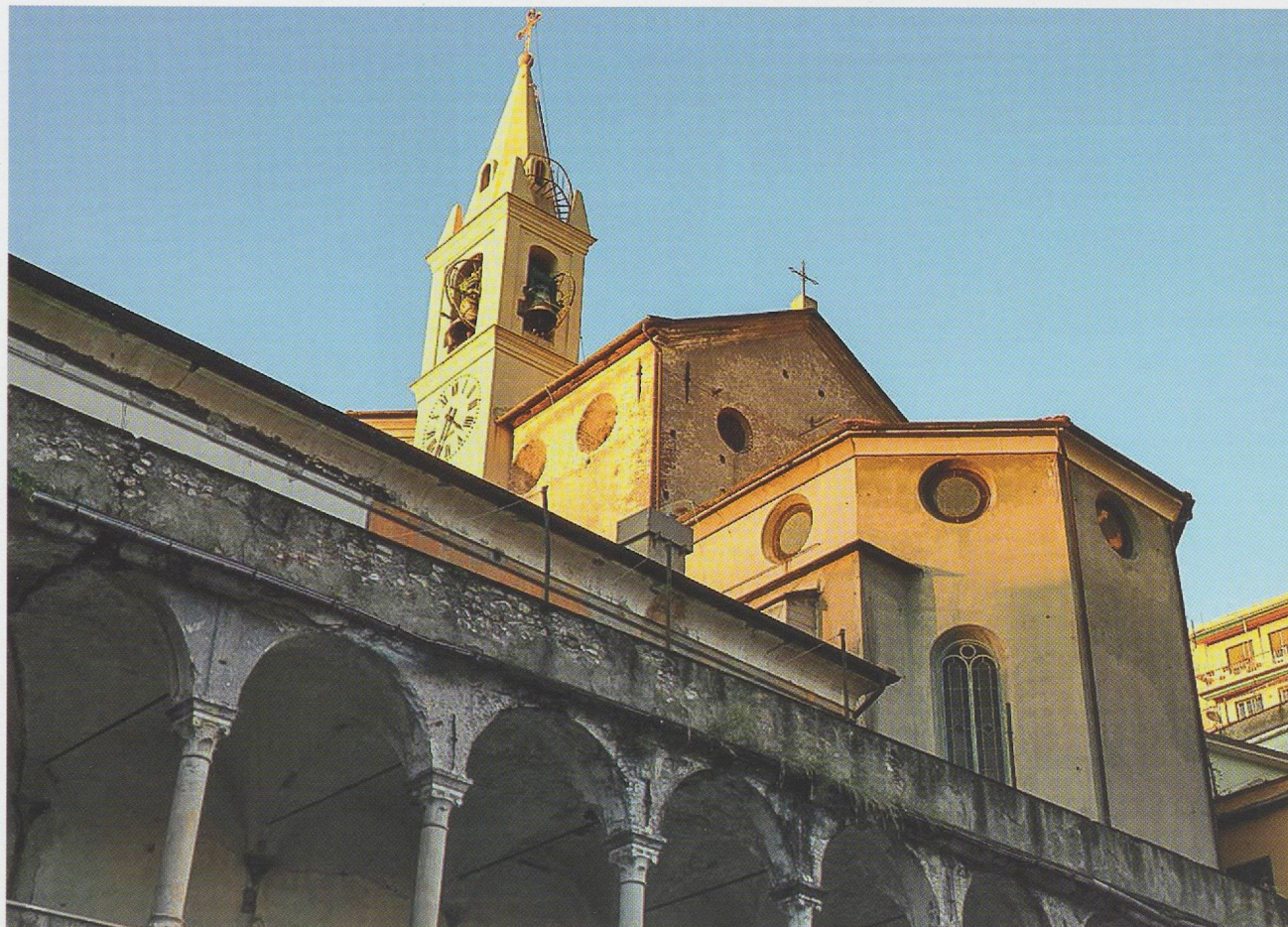
L'abside della chiesa e parte del loggiato quattrocentesco.
