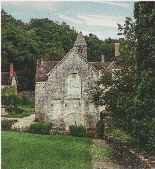
Fig. 3 - Chartreuse de Lugny, maison-haute, église. Photo : auteur.
