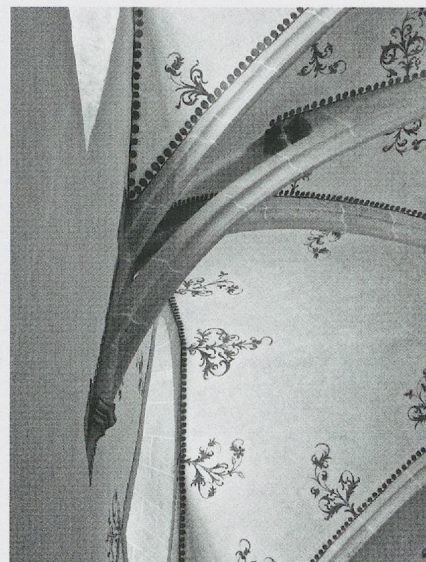
Fig. 1062. L'église Saint-Benoît à Bienne (Berne). Voûte à doubleau détaché, peu après 1457, sans doute par le maître Wenzlin, d'origine morave (photo MG, 2011).
