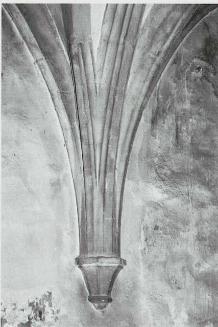
Fig. 1031 a et b. Le cloître du couvent des Cordeliers d'Annecy: les voûtes de l'aile «méridionale» et l'une des retombées sur culot (photos MG, 1979).
