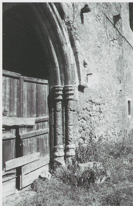
Fig. 1025. Le couvent des Franciscains conventuels de La Chambre (Savoie), fondé en 1365, actuellement en ruines: le piédroit sud du portail à colonnettes, à base et à chapiteaux évolués (photo MG, vers 1980).
