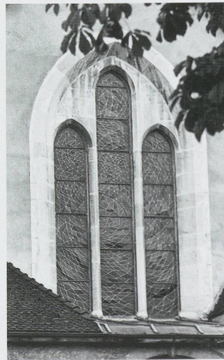
Fig. 996. L'église du couvent des Cordeliers de Cluses, en Faucigny. La fenêtre de la façade ouest, avec triplet à simples lancettes (photo carte postale, détail).
