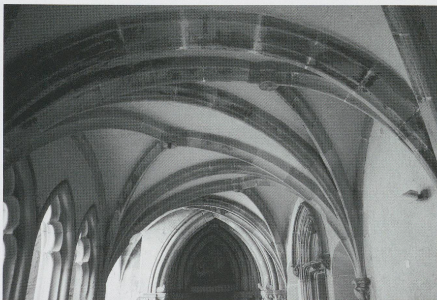
Fig. 1013. Le cloître du couvent clunisien du Bourget-du-Lac (Savoie): le rez-de-chaussée de l'aile orientale, antérieur à 1482, avec ses voûtes singulières, à trois nervures alternées (photo MG, 2005).
