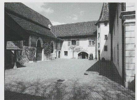
Fig. 1004. L'ancien couvent bénédictin de Saint-Pierre à Môtiers-Travers NE. Vue de la cour, avec l'église et sa grande chapelle au nord (photo MG, 2011).
