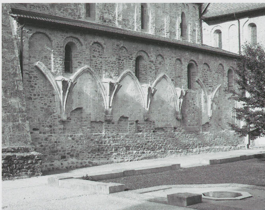
Fig. 1014. L'ancien cloître de l'abbaye clunisienne de Romainmôtier: la série des retombées de la voûte de l'aile nord (photo MG, 2010).
