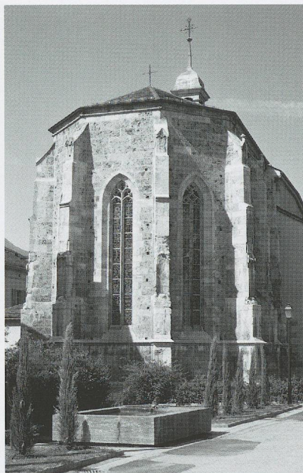
Fig. 787. L'église Saint-Théodule à Sion. Le chevet avec ses contreforts à ressauts, enrichis de niches (photo MG).
