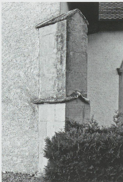
Fig. 749-750. L'église Notre-Dame d'Orny. La chapelle de Crêt: le contrefort à bâtière et à larmier intermédiaire aussi en bâtière mais à pans concaves et un culot à personnage sous feuilles de chêne (photos MG, 1969).
