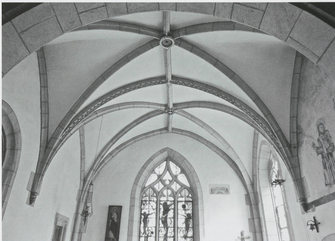
Fig. 717. L'église Saint-Pierre de Carignan. La voûte du chœur de 1512/1515, avec liernes faîtières et avec doubleau aux gorges décorées de billettes (photo MG, 2011).
