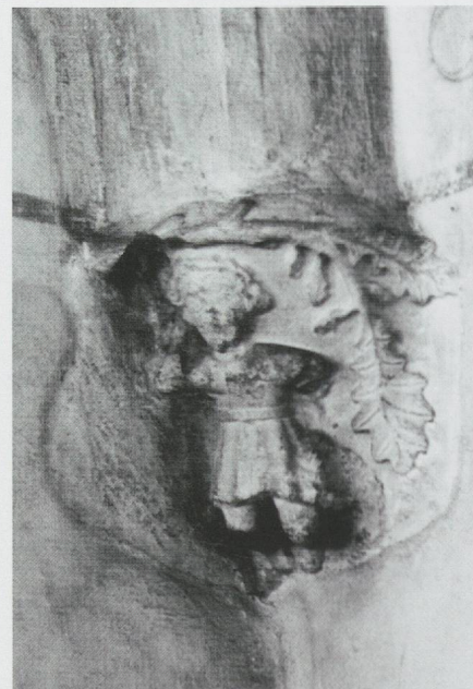
Fig. 749-750. L'église Notre-Dame d'Orny. La chapelle de Crêt: le contrefort à bâtière et à larmier intermédiaire aussi en bâtière mais à pans concaves et un culot à personnage sous feuilles de chêne (photos MG, 1969).
