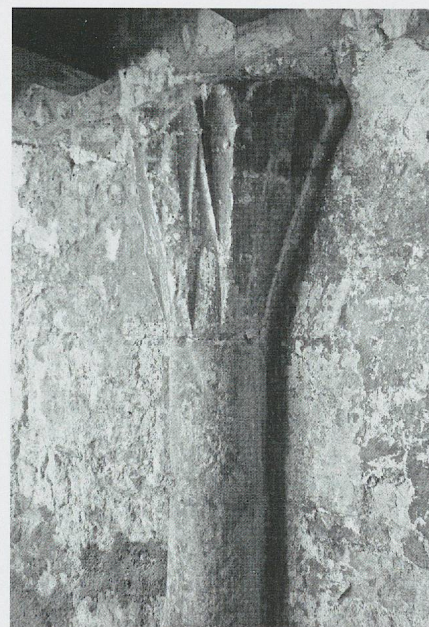
Fig. 678. L'ancienne chapelle gothique de la priorale Saint-Pierre à Môtiers-Travers. Vestige de retombées de nervures en pénétration sur une colonne engagée montrant un recouplement de cavets (photo MG, 2011).
