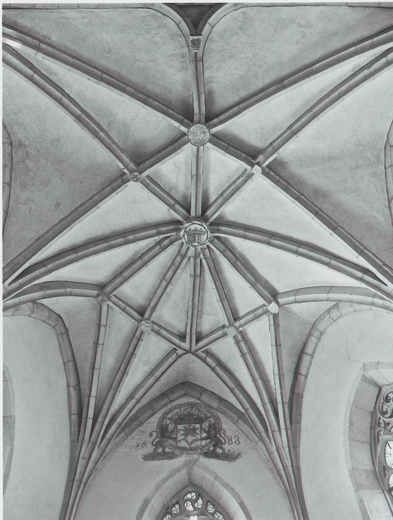
Fig. 594. L'église paroissiale de Fontaines. Le chœur hyperflamboyant du début du XVI e siècle, avec imbrication compliquée des réseaux de la travée droite et de l'abside (photo MG, 2010).
