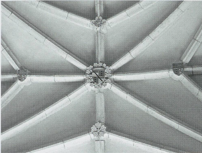
Fig. 653-654. L'église paroissiale de La Sagne NE. Clefs de l'avant-chœur avec inscription, armes des Valangin et alliés, et feuillages (photo MG, 2010), et le rayonnement serré des nervures du sanctuaire et trois de ses clefs (photo OPMS Neuchâtel, 2007).
