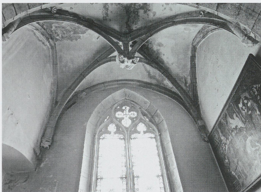
Fig. 575. L'église de La Rivière-Drueon (Doubs). La chapelle méridionale: la voûte d'ogives simples avec clef pendante soutenue par les nervures dédoublées au centre, attribuable à Antoine Lagniaz (photo MG, 2010).
