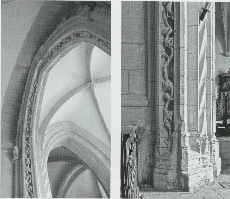
Fig. 569 a et b. L'église priorale de Miège. La chapelle des Chalons: fragment de la gorge sculptée de rinceaux et d'animaux de l'arcade d'entrée à l'ouest et la base de la colonne en hélice et des moulures de l'arcade d'entrée au nord de la travée occidentale (photos MG, 2010). – Comparer avec celle d'Orbe (fig. 531-532).
