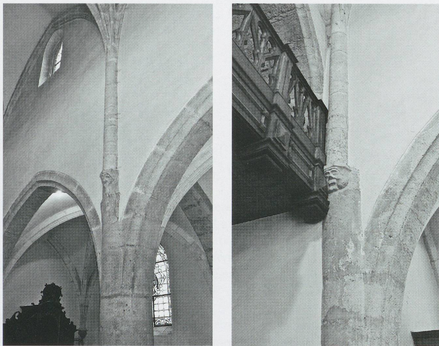
Fig. 584 a et b. L'église de Vuillafans. Deux supports du côté nord de la nef avec pile se transformant en colonne engagée, interrompue par une sorte de culot sculpté d'une tête barbue, avant 1493 (photo MG, 2010).
