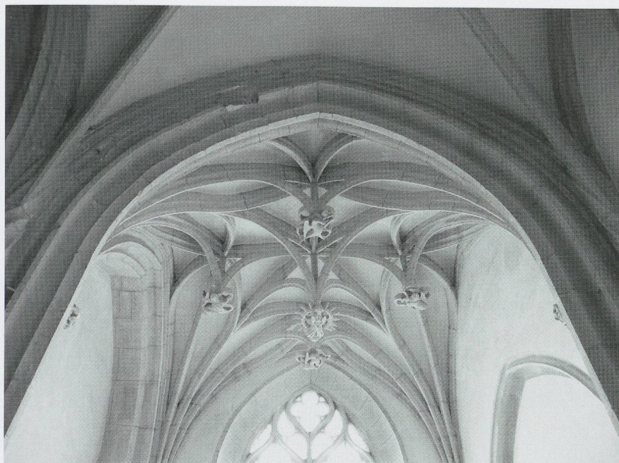
Fig. 564. L'église priorale de Mièges (Jura). La chapelle des Chalon: la voûte à clefs pendantes et nervures dédoublées de la travée orientale (fin XV e /début XVI e siècle), vue zénithale (photo MG, 2010).
