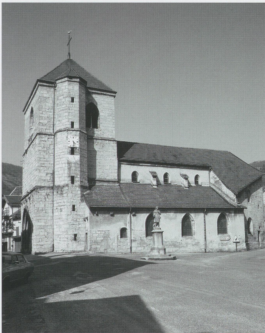
Fig. 581. La collégiale de Vuillafans (Doubs). La vue de l'ensemble du sud-ouest, avec l'annexe parementée au sud du chœur, par Lagniaz très probablement (photo MG, 1981).
