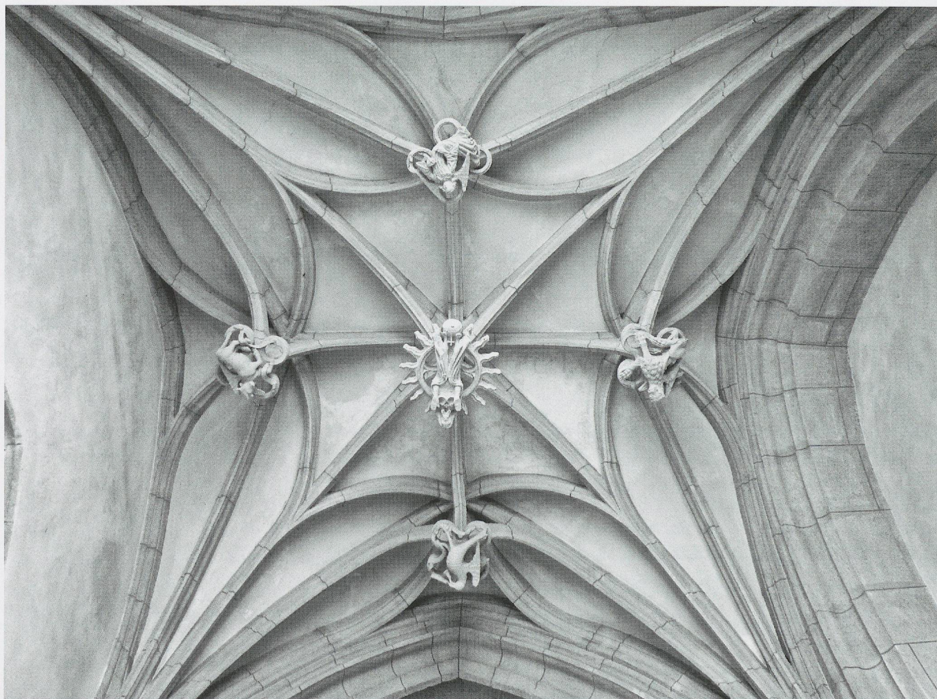
Fig. 567. L'église priorale de Mièges (Jura). La chapelle des Chalon: la voûte à clefs pendantes et nervures dédoublées de la travée orientale (fin XV e /début XVI e siècle), vue vers l'est (photo MG, 2010).
