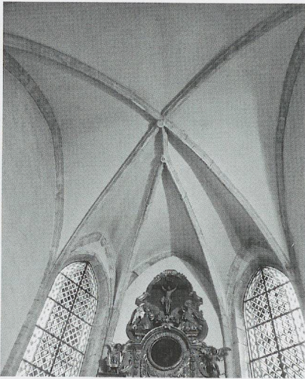
Fig. 582. L'église de Vuillafans. La croisée d'ogives du chœur aux armes des comtes de Neuchâtel ne montrant sur l'abside même qu'une courte lierne et deux longs tiercerons, avant 1493 (photo MG, 2010).
