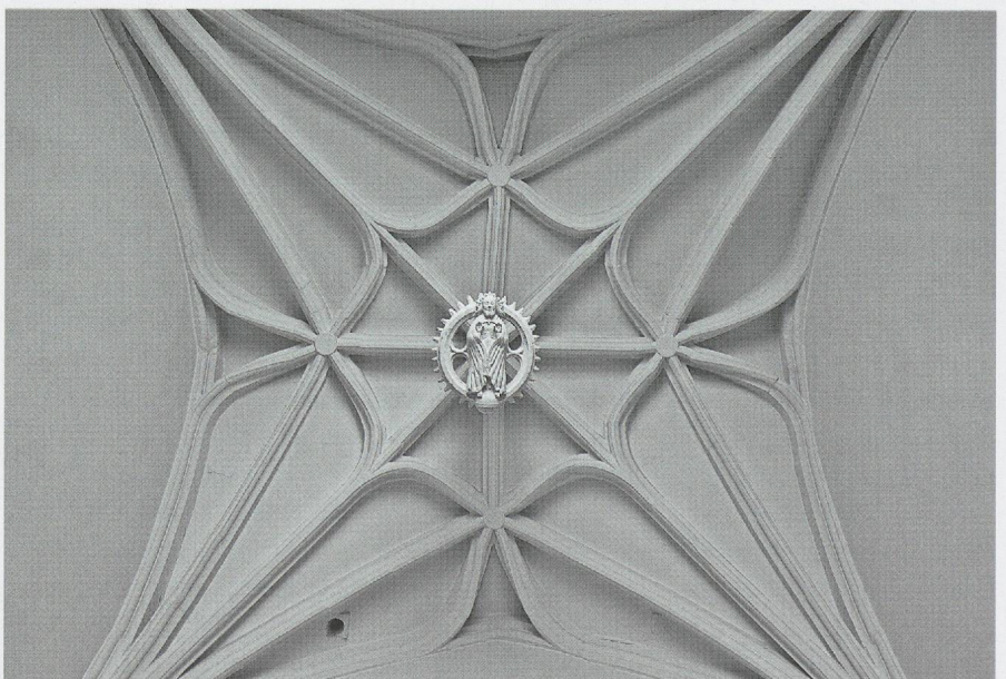
Fig. 572 a et b. L'église Saint-Laurent d'Arc-sous-Montenot (Doubs). L'ancienne chapelle des Chalon: la clef pendante conservée figurant le Christ ressuscité montrant ses plaies et la voûte complexe avec clef pendante, remontée dans la sacristie en 1835, lors de la reconstruction de l'église (photos Jérôme Mongreville, 2007, DIPRFC, Besançon).
