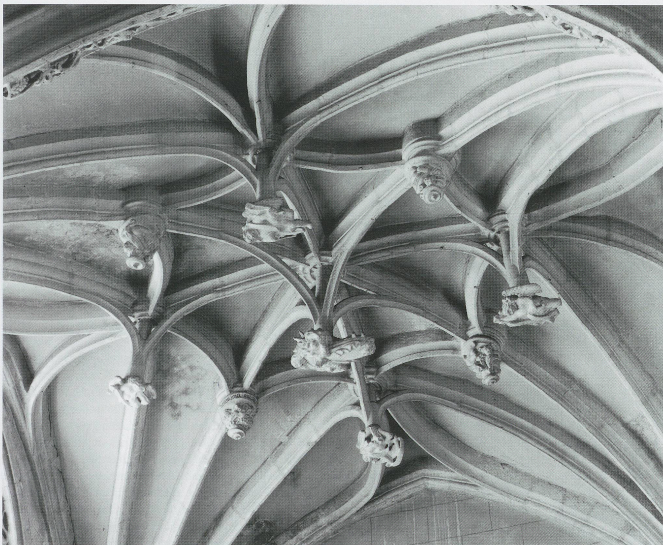
Fig. 526. Notre-Dame d'Orbe. La chapelle de la Vierge: la voûte vue vers le sud-est. La clef principale et les clefs secondaires sont en partie soutenues par des nervures dédoublées (photo Claude Bornand, 2011).
