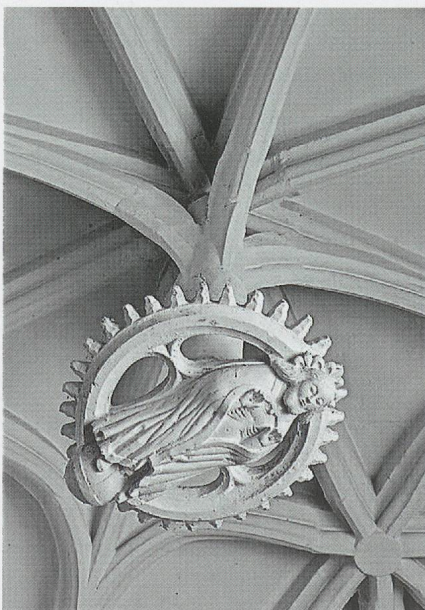
Fig. 572 a et b. L'église Saint-Laurent d'Arc-sous-Montenot (Doubs). L'ancienne chapelle des Chalon: la clef pendante conservée figurant le Christ ressuscité montrant ses plaies et la voûte complexe avec clef pendante, remontée dans la sacristie en 1835, lors de la reconstruction de l'église (photos Jérôme Mongreville, 2007, DIPRFC, Besançon).
