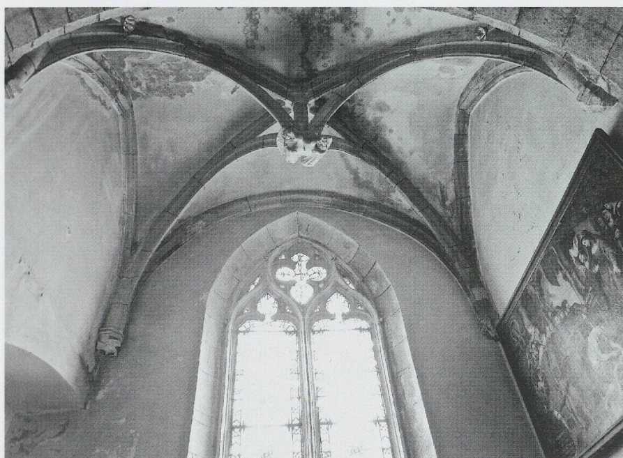
Fig. 575. L'église de La Rivière-Drugeon (Doubs). La chapelle méridionale: la voûte d'ogives simples avec clef pendante soutenue par les nervures dédoublées au centre, attribuable à Antoine Lagniaz (photo MG, 2010).
