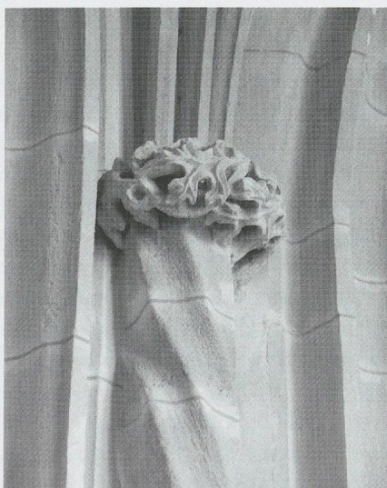
Fig. 565. L'église priorale de Mièges. La chapelle des Chalon: la base de la colonne en hélice et celles des moulures du doubleau au sud de la travée orientale (photo MG, 2011).
