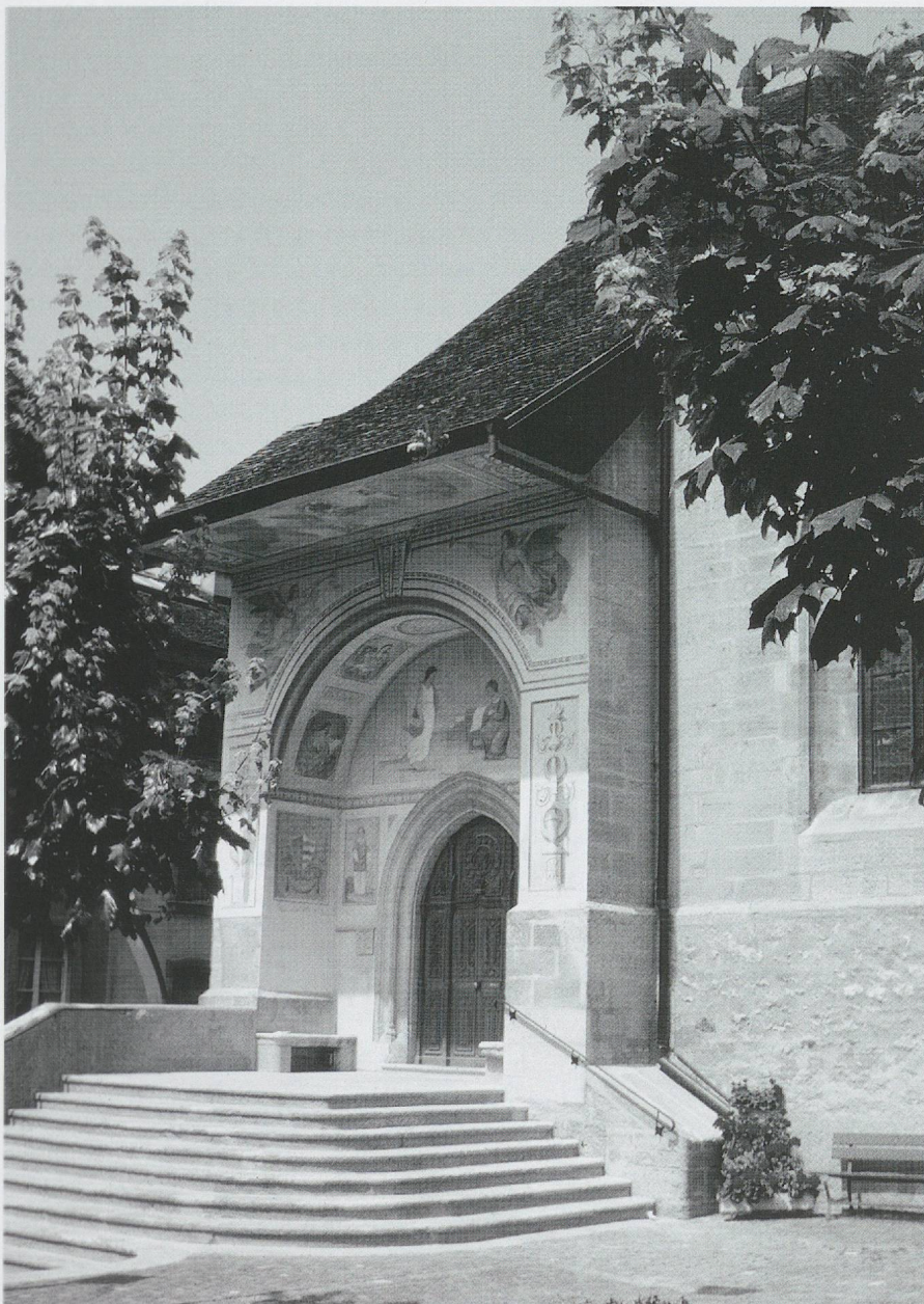
Fig. 444. L'église Saint-Laurent à Estavayer. Le portail principal avec son encadrement en berceau formant un porche massif, dû sans doute à Gilet Franc, vers 1441/1444 (photo MG, 1996).
