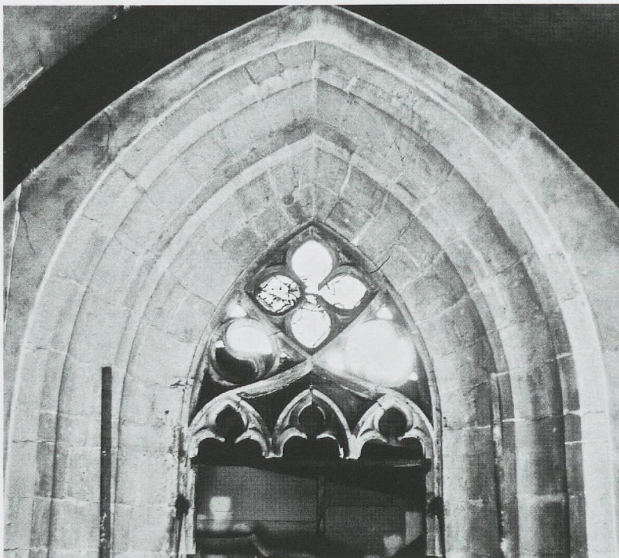
Fig. 443. L'église Saint-Laurent à Estavayer. La fenêtre nord de la travée primitive du chœur, cachée derrière l'orgue de chœur: état lors de son dégagement temporaire vers 1976 (photo Fonds Claude Jaccottet, Archives cantonales vaudoises).
