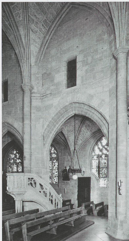
Fig. 452. Notre-Dame de Romont. L'avant-dernière travée de la nef, côté nord: piliers hexagonaux à colonnes engagées soutenant les voûtes de 1481–1486. Malgré les ouvertures orthogonales, les parties hautes sont restées aveugles entre les deux toits, à l'encontre de celles du sud, sans doute parce que la face nord était trop exposée aux intempéries (photo Yves Eigenmann, SBC Fribourg).
