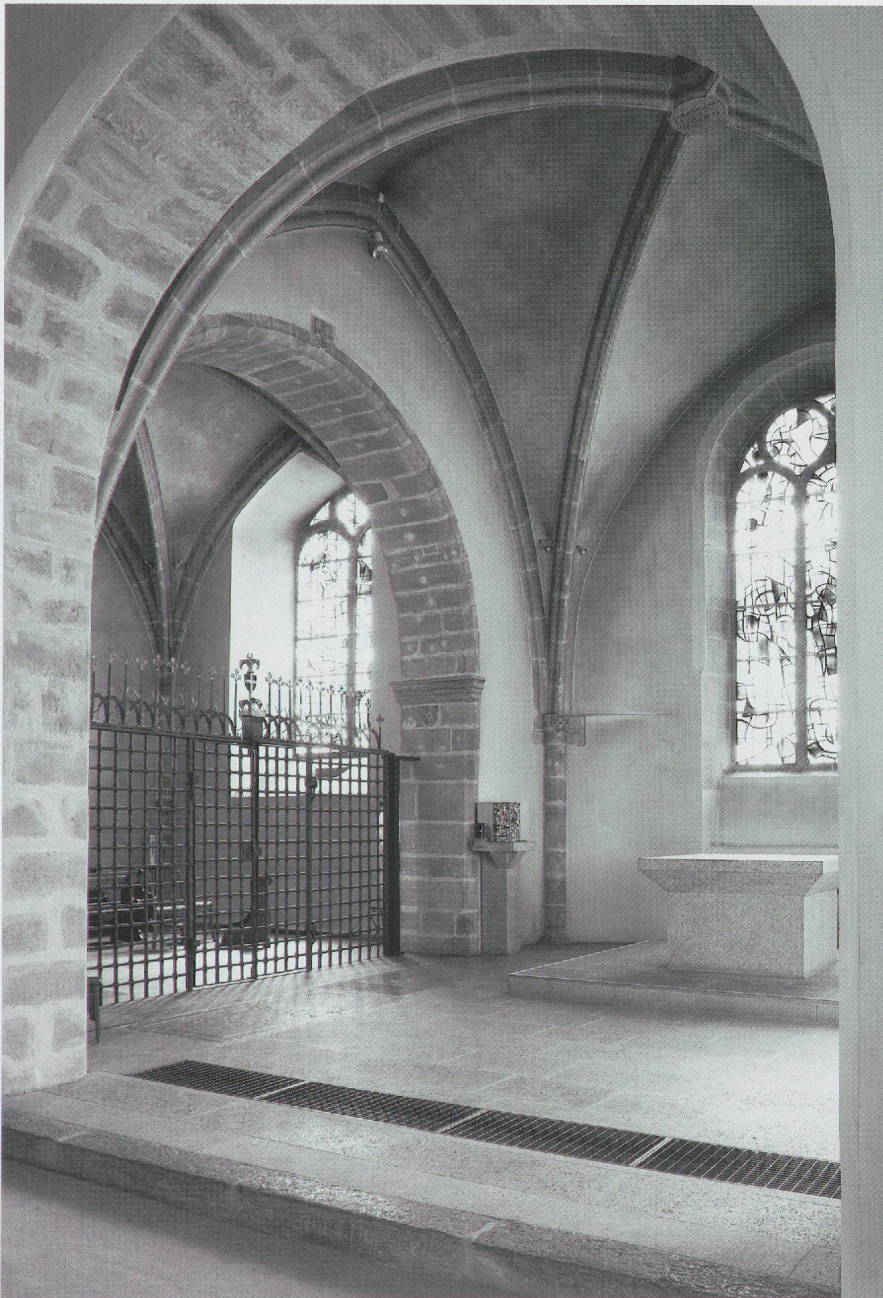
Fig. 435. L'église des Dominicaines d'Estavayer. Vue du chœur vers la chapelle de la Trinité (1424-1425), séparés à nouveau par la grande grille du XV e siècle, et détail de l'angle nord-est du chœur avec la retombée de l'arcade en plein cintre de la chapelle et la colonne engagée avec les armes d'Humbert le Bâtard (photo Yves Eigenmann, SBC Fribourg, 2013). Voir fig. 426.
