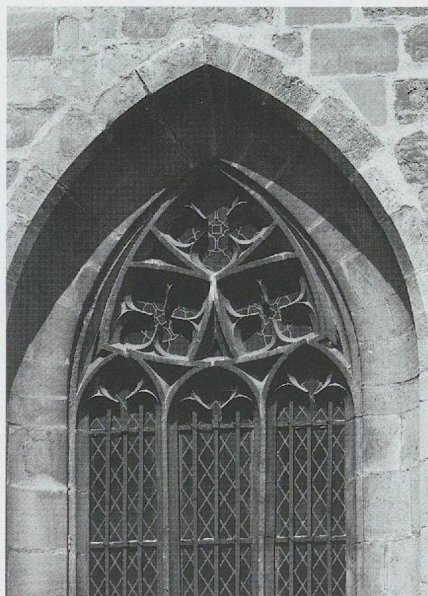
Fig. 441. L'église Saint-Laurent à Estavayer. L'ancienne fenêtre axiale de la travée primitive du chœur, datant de 1379/1392 et récupérée pour la face nord de la nouvelle travée au tout début du XVI e siècle.
