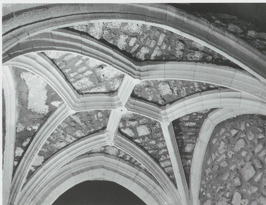
Fig. 344. Le château de Rolle: la voûte en étoile, sans ogives, de l'entrée du logis menant à la tour de Viry, vers 1520? (photo Claude Bornand).
