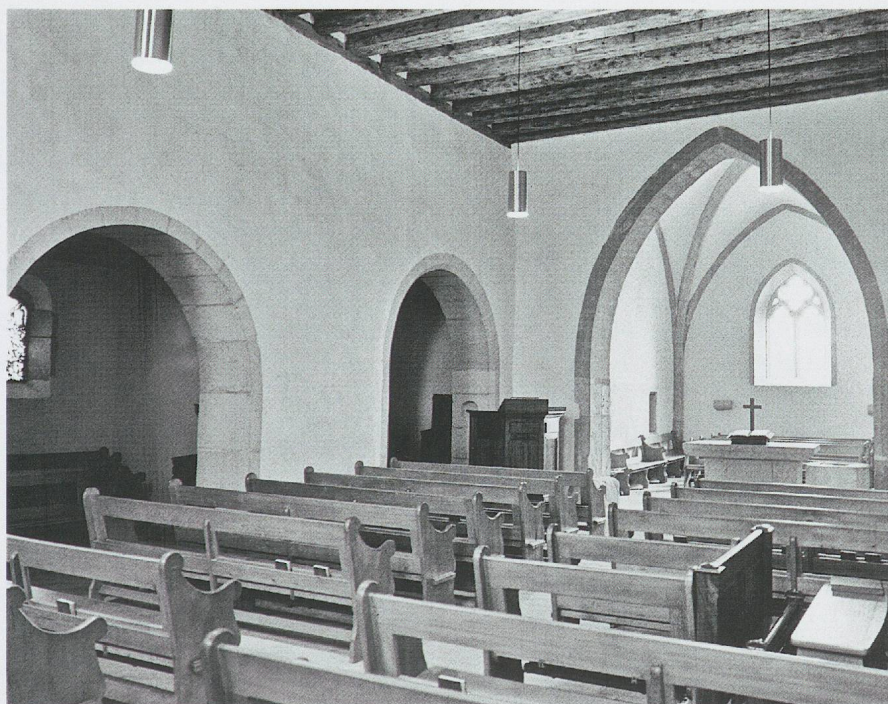
Fig. 337. L'église Notre-Dame de Genolier. Vue intérieure vers le nord-est (photo Gaston de Jongh).
