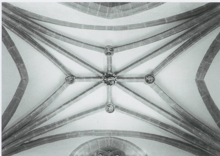
Fig. 339. L'église Saint-Martin de Bursins: la voûte en étoile de la chapelle Saint-Nicolas, vers 1518–1521 (photo Claude Bornand, 1994).
