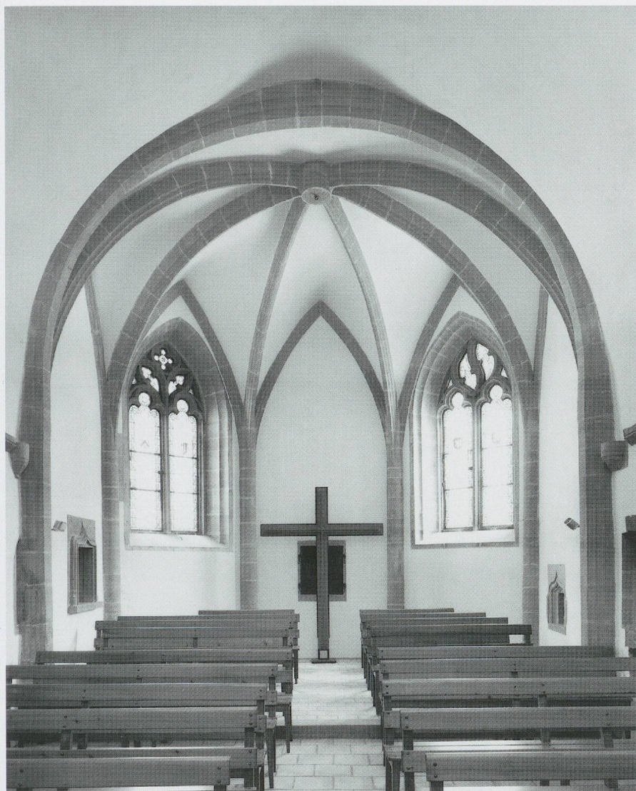
Fig. 303. L'église Saint-Martin de Bursins. Le chœur (vers 1472), attribuable à Jaquemet Palliard, de Genève. Vue intérieure, après la dernière restauration. Les remplages sont des restitutions de 1902 (photo Claude Bornand, 1994).
