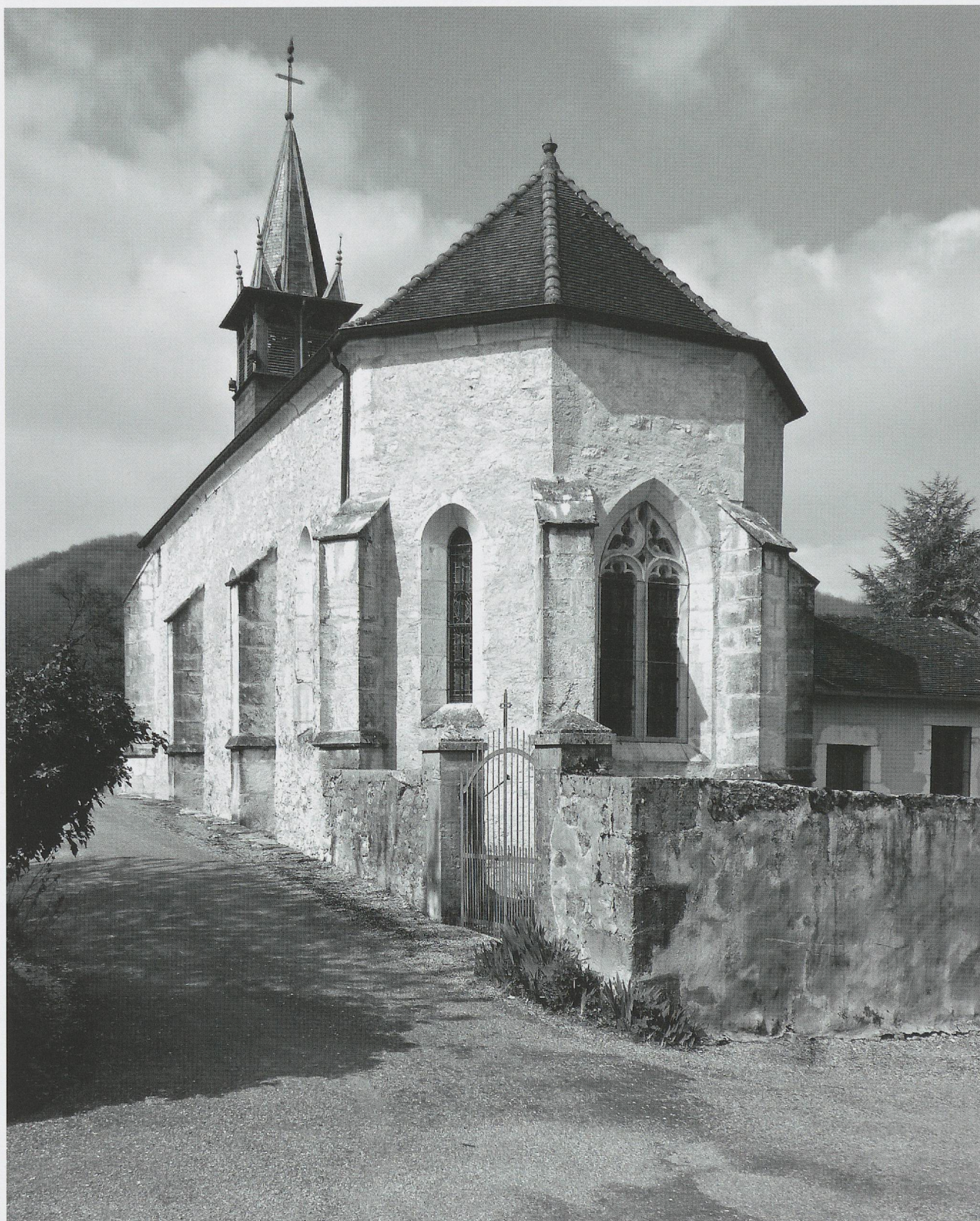
Fig. 247. L'église Saint-Maurice de Flaxieu, vers 1483: fondation de Huguenin de Montfalcon, seigneur de Flaxieu, et d'Aymon son frère. Vue du sud-est avec les «contreforts genevois» et les baies hiérarchisées (photo MG, 2010).
