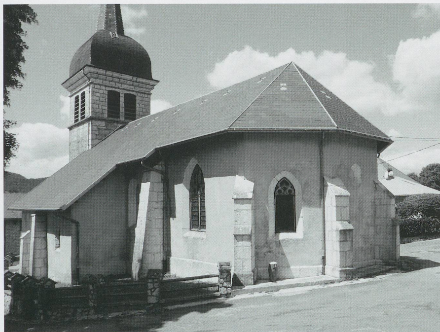
Fig. 279. L'église Saint-Amand du Grand-Abergement en Valromey. Le chevet avec ses baies variées, vu du sud-est (photo MG, 2010).
