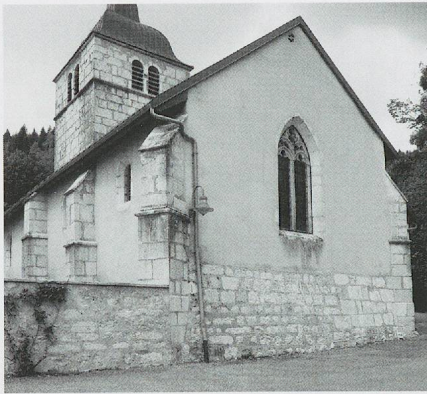
Fig. 263. L'église Saint-André de Montanges. Le chevet en bordure de terrasse, vu du sud-est (photo MG, 2011).
