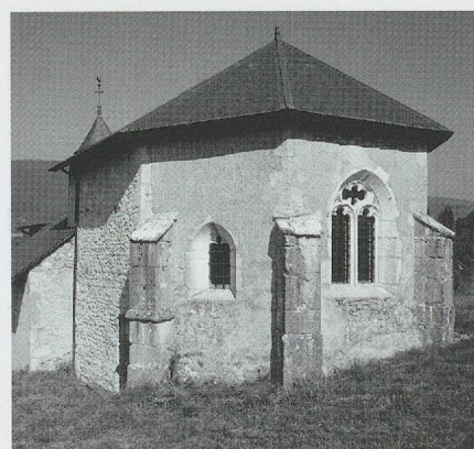
Fig. 286. L'église Saint-Maurice de Lilignod. Le chevet vu du sud-est (photo MG, 1980).
