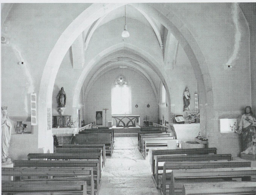
Fig. 262. L'église Saint-André de Montanges. Vue de l'intérieur, de la nef vers le chœur: nef, premier arc triomphal avec ses deux lunettes, croisée surélevée, second arc triomphal et chœur (photo MG, 2011).
