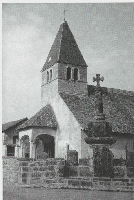
Fig. 283. L'église Notre-Dame de Vieu. Le clocher avec ses baies jumelées à encadrements toriques: état ancien (photo MG, vers 1970). Voir fig. 107.
