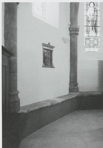
Fig. 260. L'église Saint-Maurice de Corbonod. Le banc en pierre du chœur: partie nord (photo MG, 2012).
