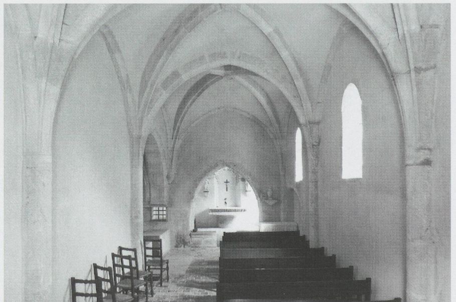
Fig. 252. L'église Saint-Oyend de Vongnes en Bugey. L'intérieur de la nef vu vers le chœur (photo MG, 2010).
