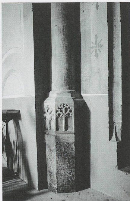
Fig. 215. L'église Saint-Etienne de Dingy-Saint-Clair. Une base de support à fenestration dans le chœur, avant 1531 (photo MG, 1971).
