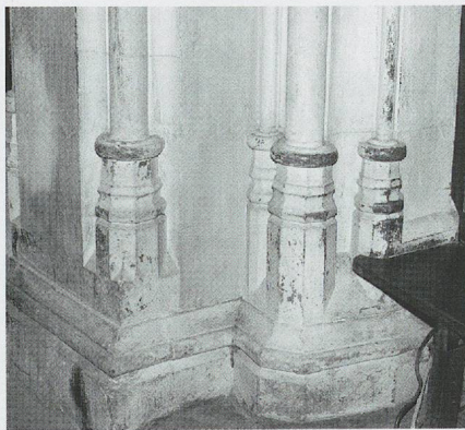
Fig. 238. L'ancienne église des Dominicains d'Annecy. Les bases du support médian au nord de la chapelle de Janus de Savoie, fondée en 1478 (photo MG, 1978).
