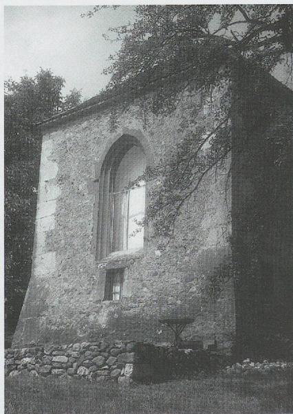
Fig. 217. La chapelle de la maladière de Vège (paroisse de Cornier), de la fin du XV e siècle. La «façade» (photo MG, 1969).
