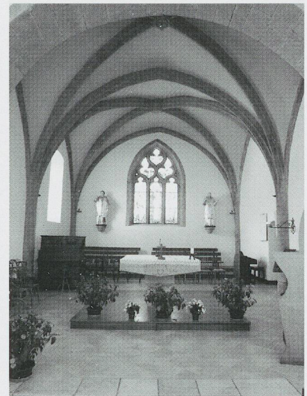
Fig. 203. L'église Saint-Etienne de Ballaison. L'intérieur du chœur de 1471/1480 (photo MG, 2010).
