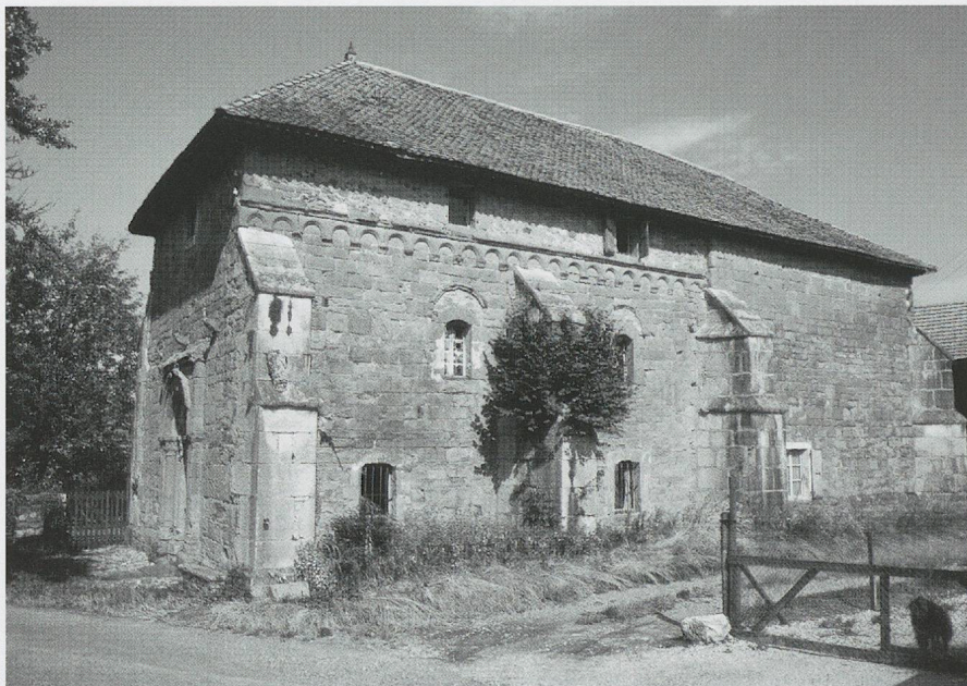
Fig. 222. La chapelle de Moussy (Cornier). L'extérieur du flanc sud, avec ses soutiens sous forme de contreforts «genevois» épaissis (photo MG, 1979).
