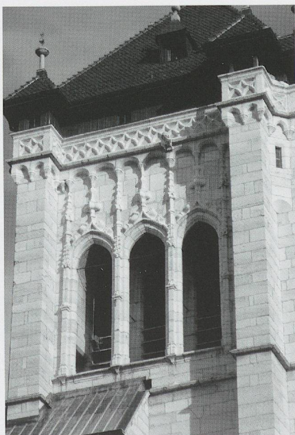
Fig. 176. La cathédrale Saint-Pierre de Genève. La tour sud, commencée en 1510 et non terminée en 1530: les grandes baies et la coursère occidentale (photo MG, 2009).
