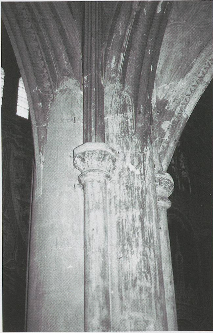
Fig. 160. L'ancienne église des Cordeliers de Chambéry. Une des piles «cylindriques» de l'abside avec colonnes engagées à chapiteaux de feuillages portant les ogives, vu du déambulatoire (photo MG, 1978).
