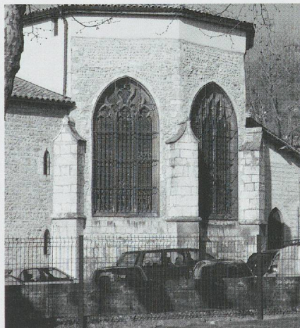
Fig. 191. L'église paroissiale d'Arenthon en Faucigny (peu avant 1516): le chevet du chœur avec ses fenêtres légèrement hiérarchisées et ses contreforts insolites (photo MG, 2013).
