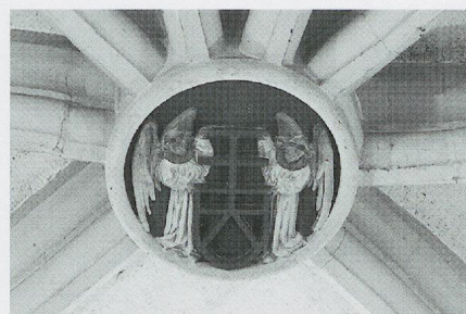
Fig. 111. L'église Notre-Dame-la-Neuve, à Genève. Le chœur semi-octogonal, couvert par une seule voûte d'ogives à huit nervures aboutissant à une unique clef aux armes de Clément Poutex (photo MG, 2009).
