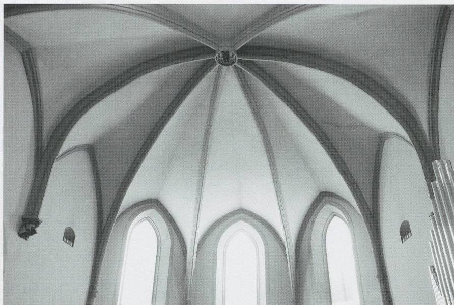
Fig. 111. L'église Notre-Dame-la-Neuve, à Genève. Le chœur semi-octogonal, couvert par une seule voûte d'ogives à huit nervures aboutissant à une unique clef aux armes de Clément Poutex (photo MG, 2009).
