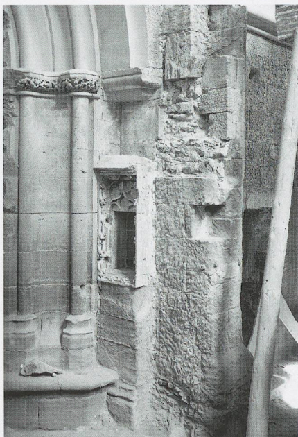
Fig. 39. Genève, chapelle des Macchabées. Piédroit du portail gothique, en partie conservé et retrouvé vers 1887, en cours de restauration, dans l'épaisseur de l'ancienne porte (photo coll. Jacques Mayor, CIG/BGE).
