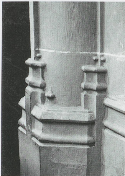
Fig. 13. L'église Saint-Martin de Vevey. Pilier de la nef avec colonne engagée à listels (photo MG, 1967).
