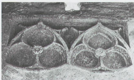
Fig. 30. Estavayer, rue des Thioleyres, 22. Les linteaux gothiques flamboyants de type «fribourgeois» au 1 er étage (photo MG, 2012).
