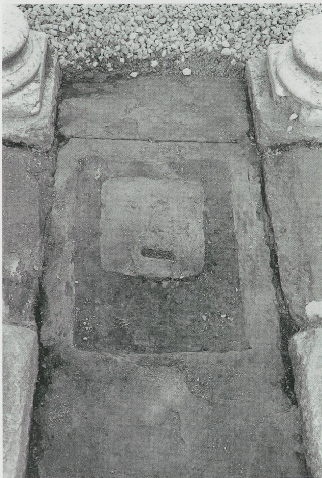
Fig. 44. Le tétrastyle St.8, détail de la dalle centrale d'origine.
