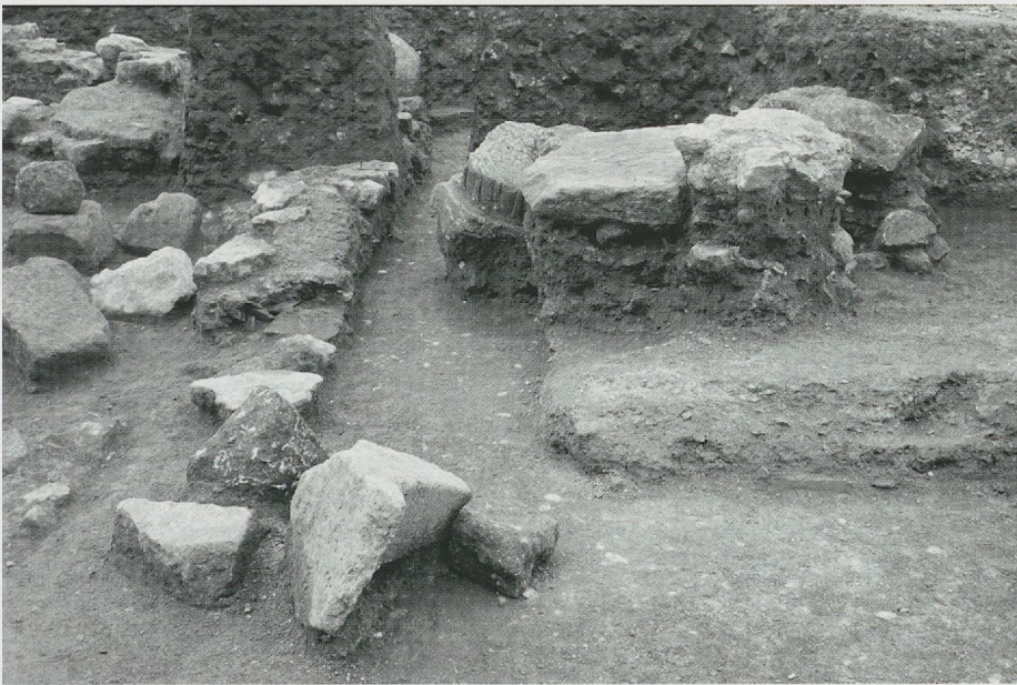
Fig. 38. Temple carré, fondation M8 du départ de l'escalier, partie est, avec au fond la dalle de parapet. Vue de l'ouest.
