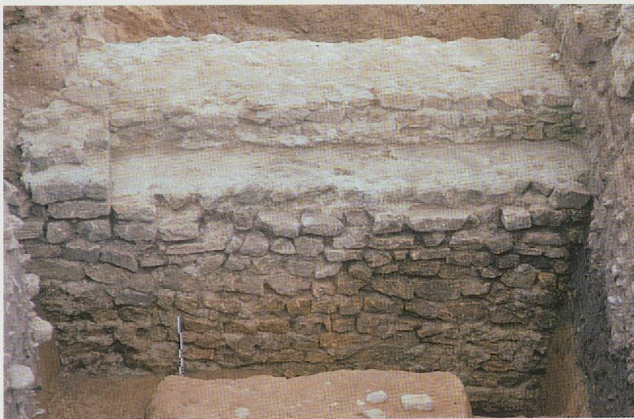
Fig. 57. Podium du temple carré, réaménagement tardif du mur occidental M1W. Vue de l'ouest.
