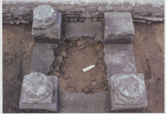
Fig. 43. Le tétrastyle St.8. après enlèvement de la dalle centrale moderne et de son sommier de béton.
