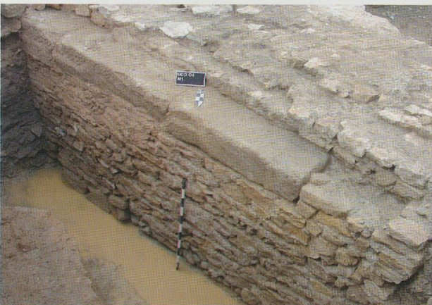
Fig. 12. Temple carré, mur est M1E du podium, avec dalles et empreintes de dalles de grand appareil du parement. Vue du nord-est.
