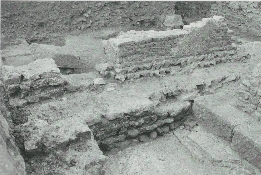
Fig. 51. L'annexe ouest. Mur oriental M11, partie sud, face est et sol adjacent. Vue de l'est.
