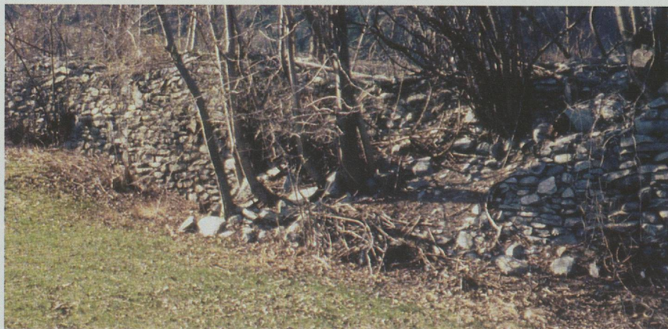
Abb. 101 — Aufnahme eines Abschnitts der mittelalterlichen Schutzmauer von Gamsen vor der Restaurierung.
