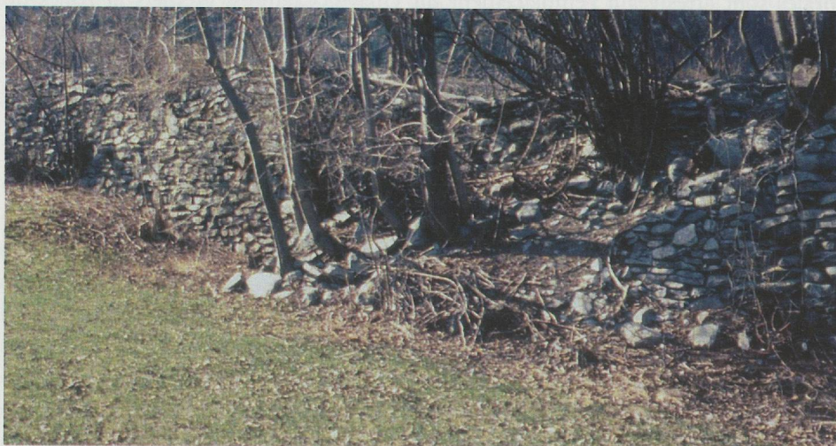
Fig. 101 — Vue d'un des tronçons du mur médiéval de Gamsen avant sa réhabilitation.
