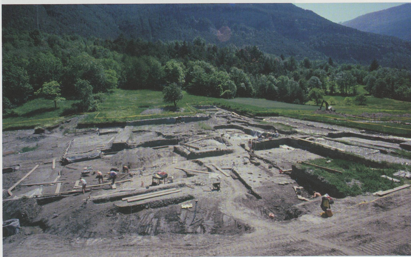
Fig. 24 — Le secteur du cône torrentiel de Waldmatte-est en cours de fouille (1990). La forme en éventail caractéristique de ce genre de formation est très perceptible sur cette vue prise en direction du versant du Glishorn.
