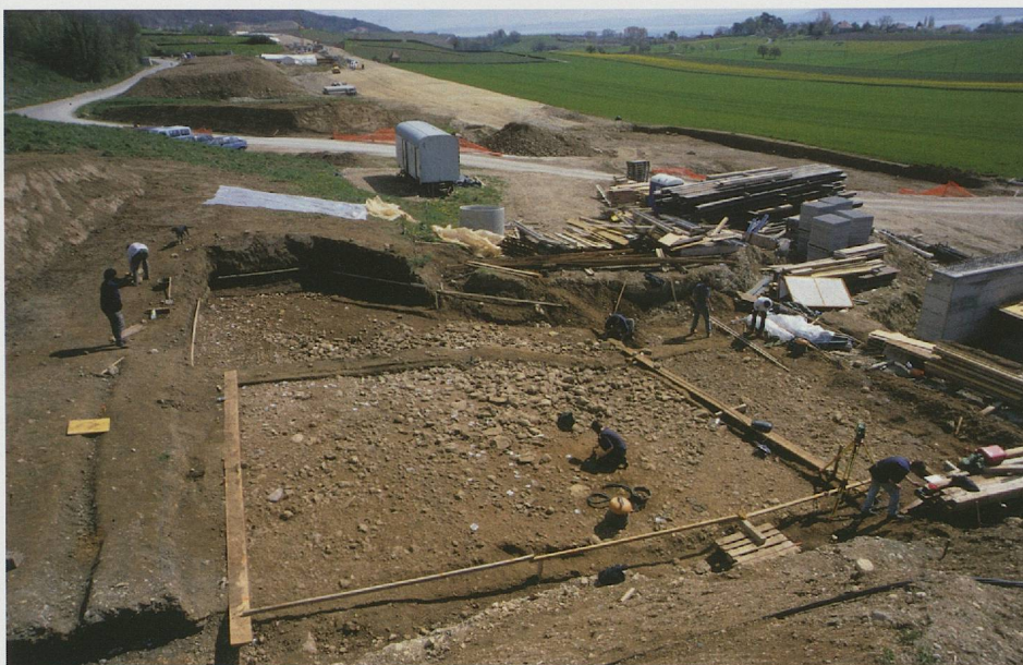
Fig. c — Secteur 1/Empièchement 154. Premier décapage, avril 2002.
