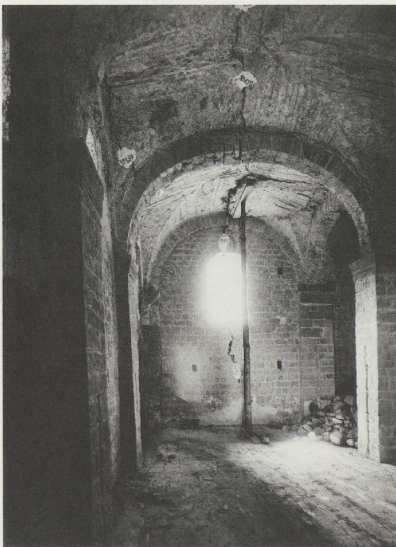
FIG. 137 — La chapelle Saint-Michel pendant les travaux, 1904
