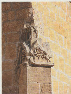
FIG. 57 — Détail du dais du contrefort sud
