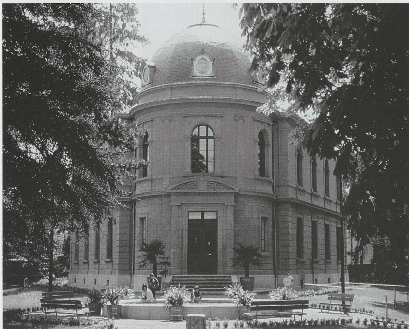
Fig. 305 : Le Musée Schwab en 2003, après la rénovation du bâtiment.
