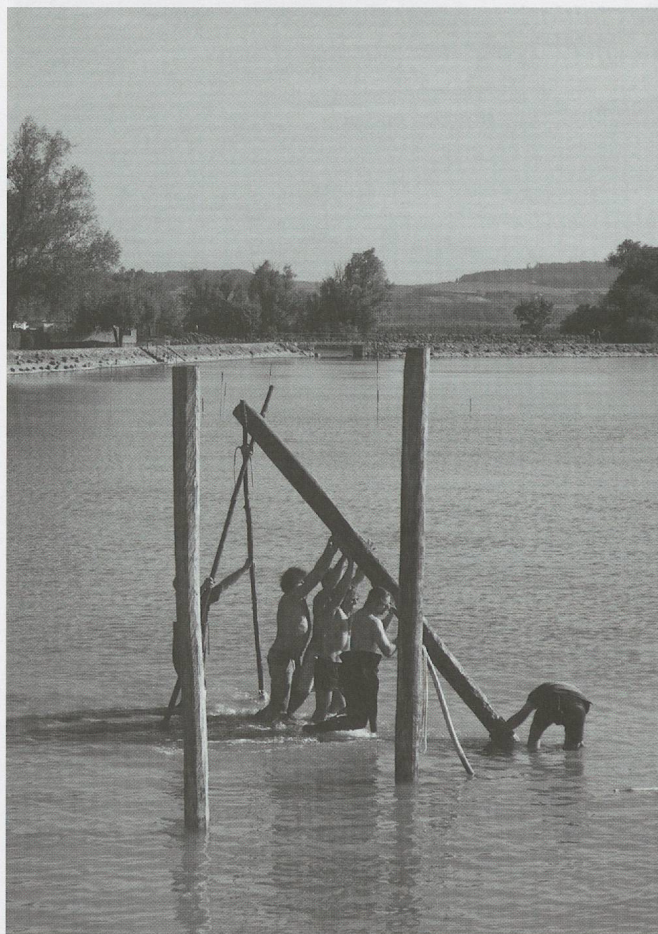
Fig. 318 : Expérimentation de l'enfoncement in situ des pieux en chêne d'une pile du pont Vouga à La Tène par l'archéologie cantonale neuchâteloise et le Laténium, en septembre 2007.
