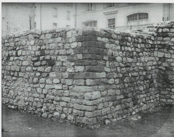
Fig. 49. Nyon, Musée romain, fouilles 1974. Vue sud-ouest du chaînage d'angle des murs M 2008-2009.
