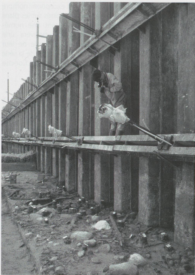
Fig. 11. Vue en direction de l'est de la banquette témoin des secteurs 33c à 35 (zone 1) conservée le long des palplanches : les bois couchés attribués au village Bronze ancien de l'ensemble E11 reposent sur une plage, les pilotis des deux villages de cette période (ensembles E11 et E12) apparaissent au même niveau dans cette zone du site.
