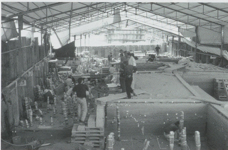
Fig. 8. Caisson principal de la zone 3 1999. Au premier plan, dégagement du sommet de la séquence du Néolithique final dans le secteur 195 et sur la gauche le secteur 214, où l'on observe les rangées parallèles des pilotis des maisons du village Bronze ancien E12 daté vers 1645 – 1620 av. J.-C.
