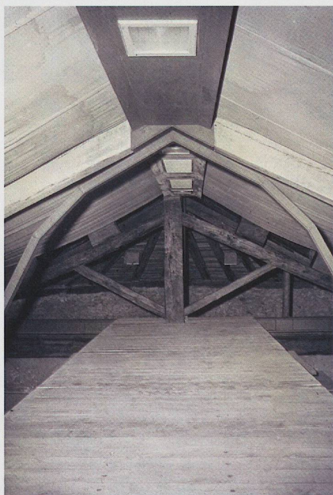
Fig. 15 — Chiesa di S. Orso – Passerella sottotetto.
