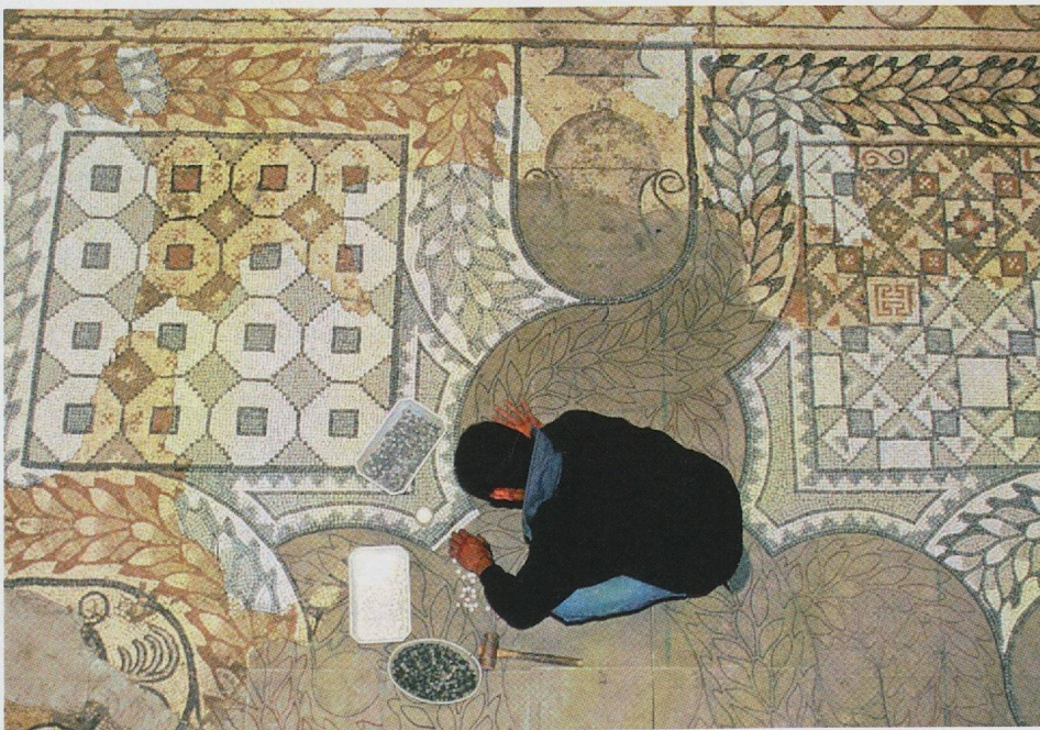
Fig. 3 — La restauration des pavements polychromes. Le choix d'un procédé de réintégration non colorée à l'aide de tesselles modernes. Réalisation Raymond Rogliano et Michel Compan (fonds ArchéOfactory, Loupian).
