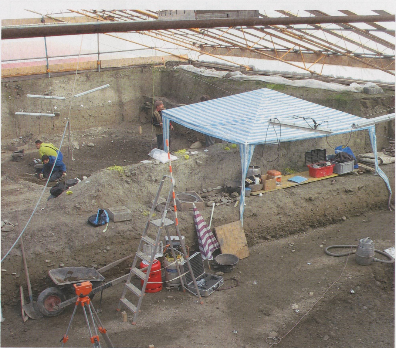
Fig. 29 — Vue générale du chantier en direction de l'est, le 15 janvier 2008. Fouille en cours du Bâtiment 1 (au second plan, derrière le témoin central).
