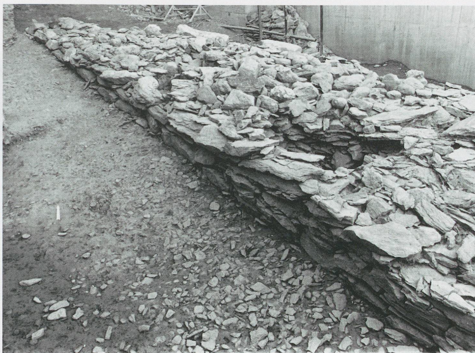
Fig. 18. Parement ouest du soubassement.
