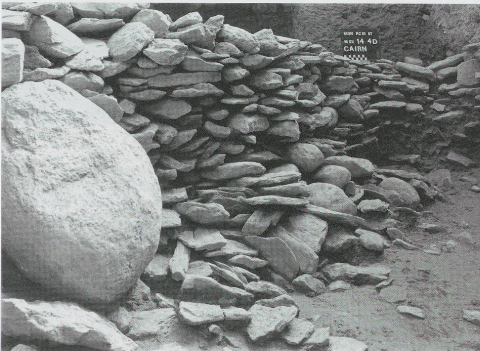
Fig. 48. Mur 4b, vue du parement nord.
