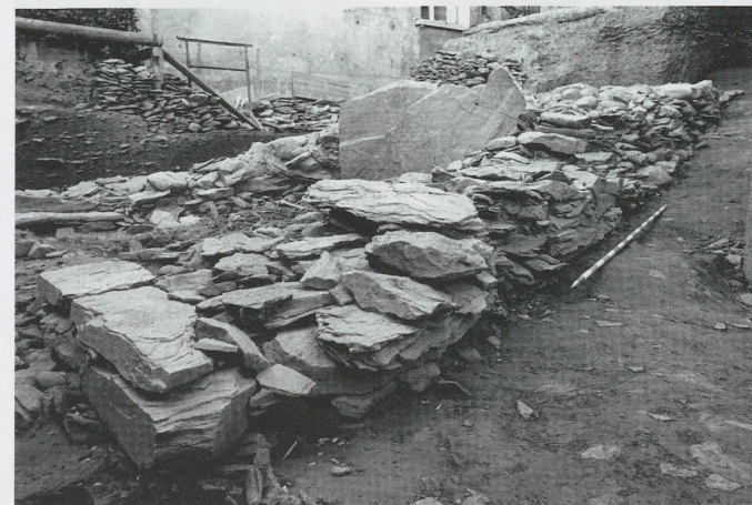
Fig. 19. Parement est du soubassement.
